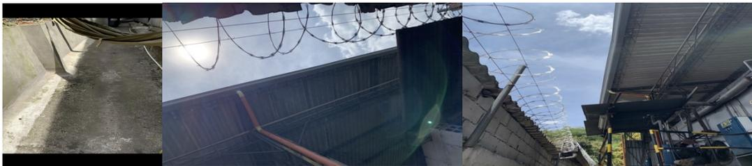
Realizando el recorrido se visualiza como el techo de la bodega vecina está apoyado sobre dicho muro, aumentando así la carga vertical, lo cual pone en riesgo la estabilidad de este, ya que este estaba construido como un muro de cerramiento y no tiene el diseño estructural adecuado para soportar cargas adicionales.
