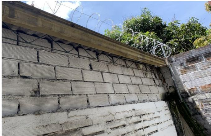
A este muro, se le realizo un trabajo de impermeabilización en revoque con sika 1, media caña con este mismo material, para evitar filtraciones en la junta del muro contra el piso en concreto, y filtraciones por el adobe. También se realiza trabajo en canoas del techo de suminfrio, para evitar que el agua lluvia se dirija hacia dicho muro
