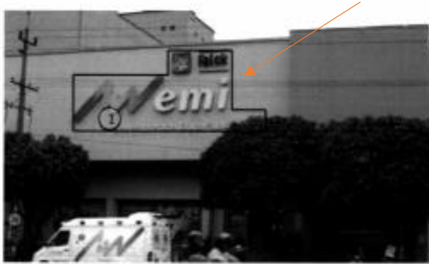
Imagen 1. Punto de instalación elemento 1
