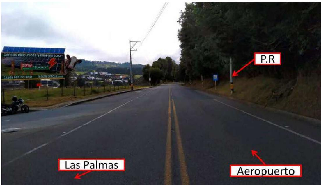
**Fotografías No. 3 y 4 Plano General:** En estas fotografías tomadas en sentido Las Palmas - Aeropuerto, se aprecian las características generales del tramo de vía donde ocurrió el accidente, la cual presenta demarcación de línea amarilla doble continua separadora de carriles, líneas blancas de borde, y señal vertical SR-06 “Prohibido girar a la izquierda”. En este sentido se desplazaban los vehículos involucrados en el accidente.
