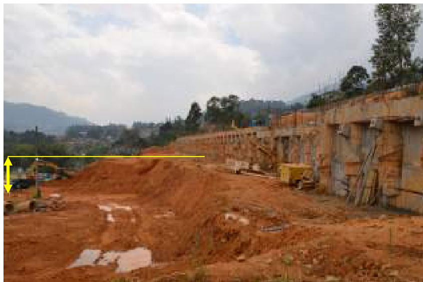
FIGURA 5. SE OBSERVA LA EXCAVACION REALIZADA EN EL TALUD INFERIOR.
