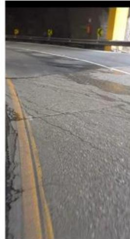
Imagen 56. Junta de pavimento rígido y flexible en el túnel
