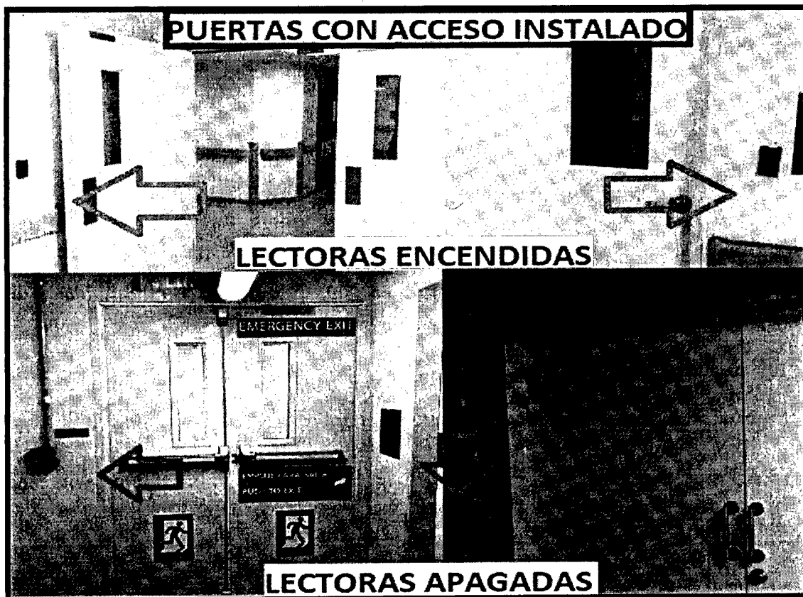
Imagen 2. Equipos Instalados Encendidos y Apagados.
