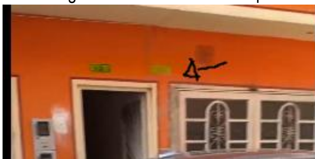
Imagen tomada el día de la inspección
