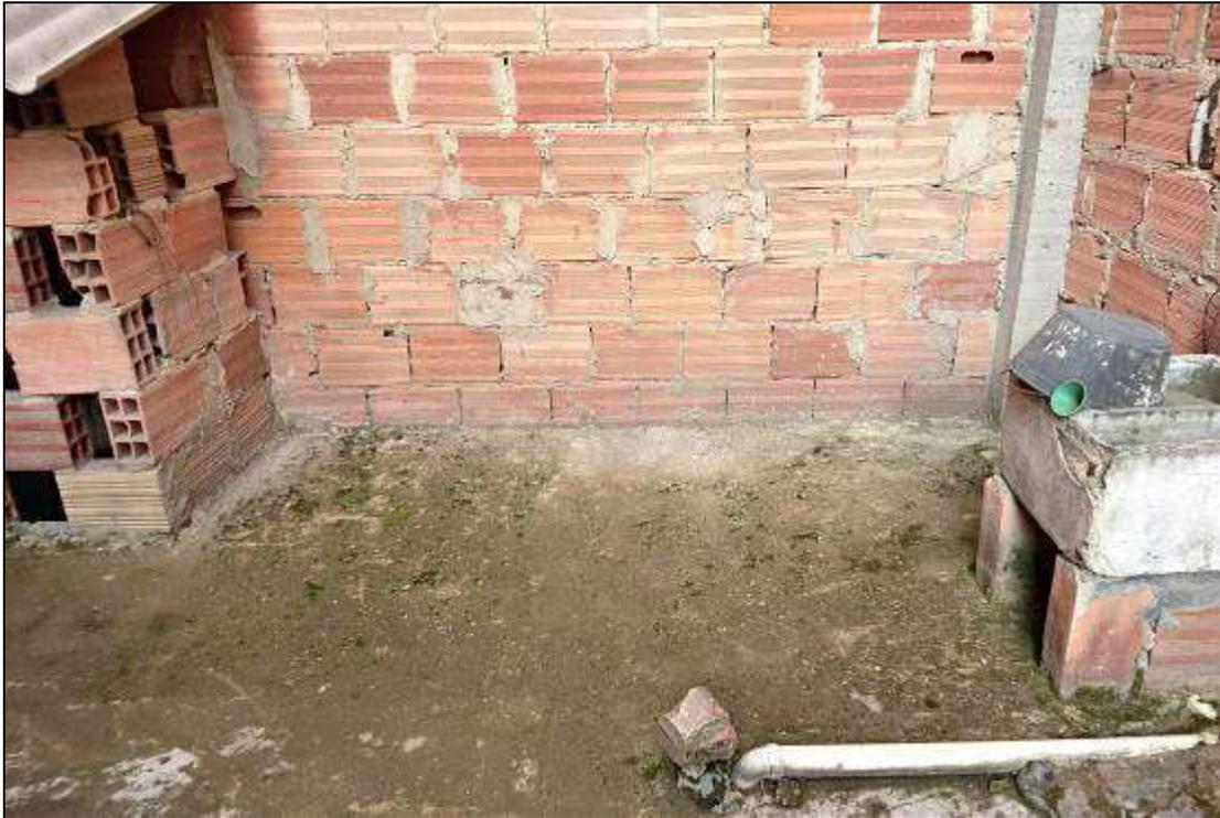
**FOTO No. 15:** Visión al fondo de la TERRAZA del predio en Litis de la KR 120 A No. 75 – 27, con visión de la placa de piso en cemento, muros laterales en bloque de arcilla, y presencia de tanque lavadero (sistema de desagües), y pozo de luz de desfogue de la cocina en primera planta.
