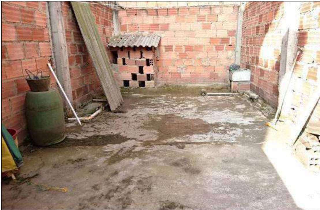
**FOTO No. 14:** Visión al interior de la TERRAZA del predio en Litis de la KR 120 A No. 75 – 27, con visión de la placa de piso en cemento, muros laterales en bloque de arcilla, y columnas laterales fundidas en concreto.
