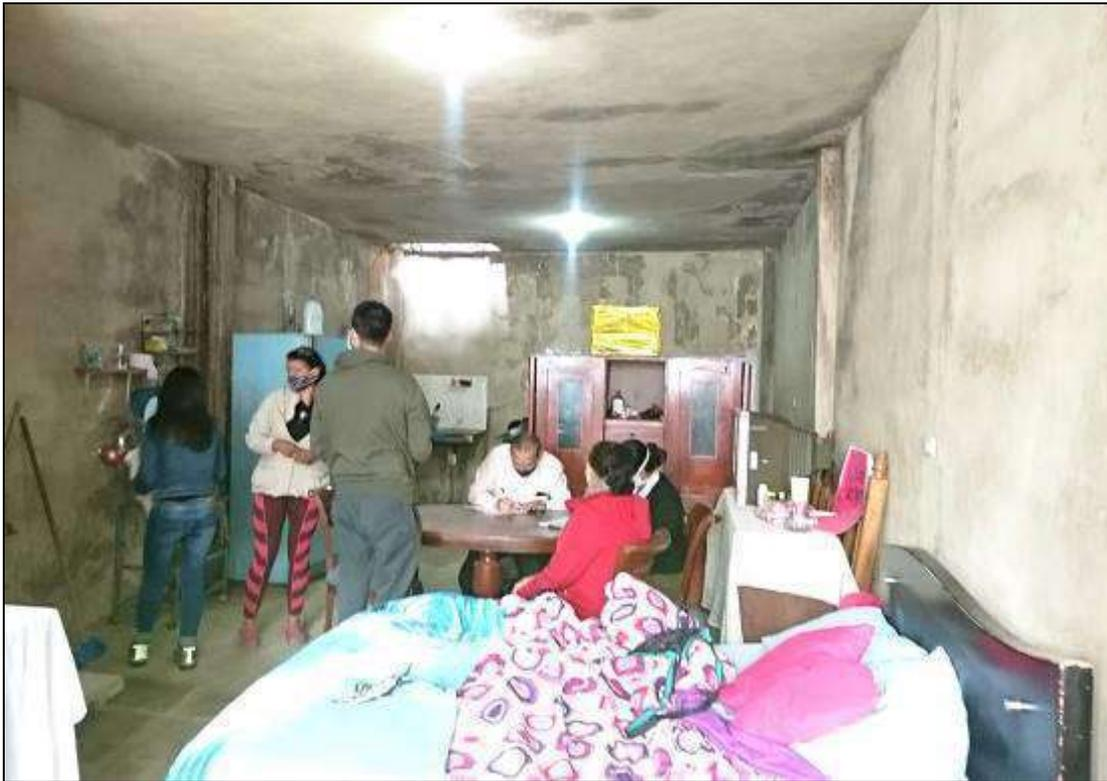
**FOTO No. 08:** Visión al interior de la PRIMERA PLANTA del predio en Litis de la KR 120 A No. 75 – 27, con visión del área de uso múltiple al fondo. Pisos en cemento. Muros pañetados y alisados. Techo en placa de concreto, en obra negra.
