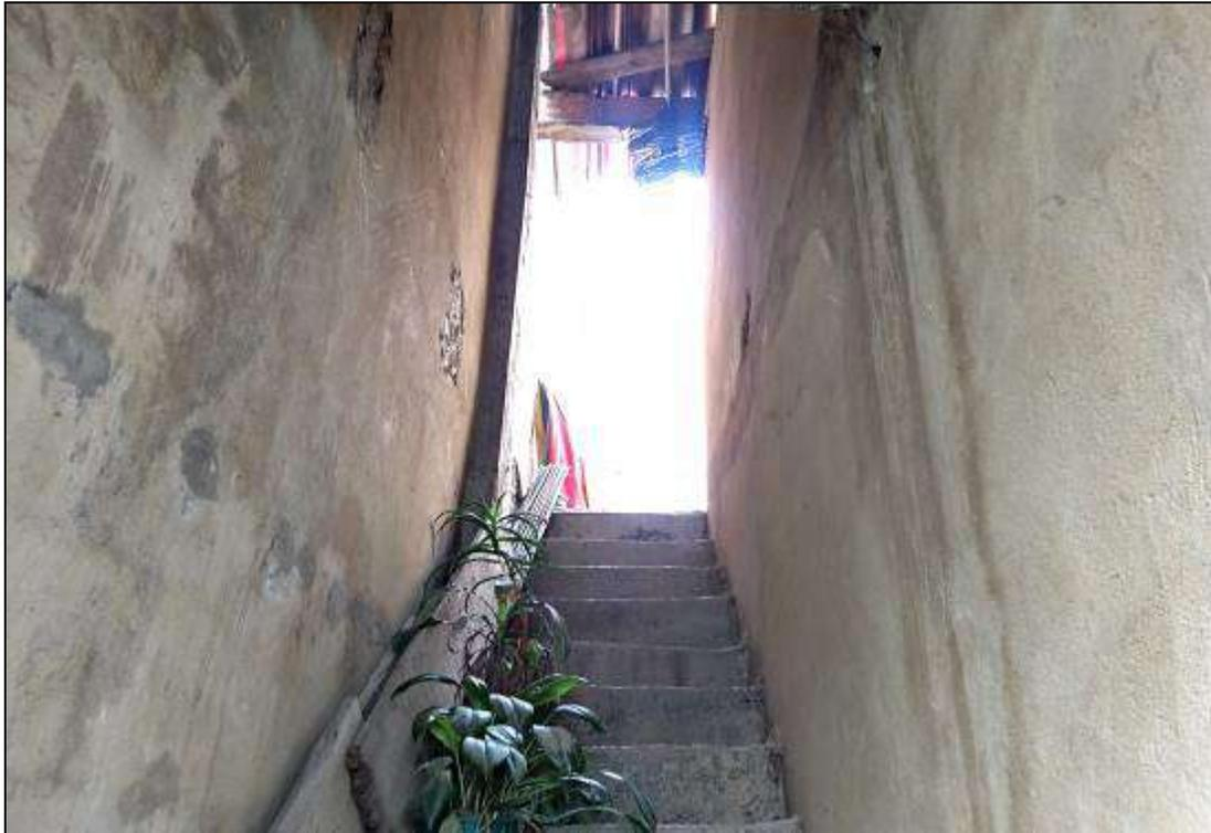
**FOTO No. 11:** Visión al interior de la PRIMERA PLANTA del predio en Litis de la KR 120 A No. 75 – 27, con visión de la escalera (1.0 metros de ancho) que de primera planta conduce a la TERRAZA del predio en litis. Pisos en cemento. Muros pañetados y alisados. Acabados en obra negra.
