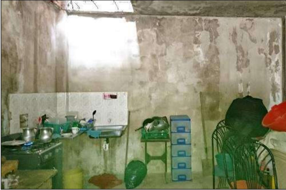
**FOTO No. 09:** Visión al interior de la PRIMERA PLANTA del predio en Litis de la KR 120 A No. 75 – 27, con visión del área de cocina al fondo, pozo de luz en la parte superior. Pisos en cemento. Muros pañetados y alisados. Techo en placa de concreto, en obra negra.
