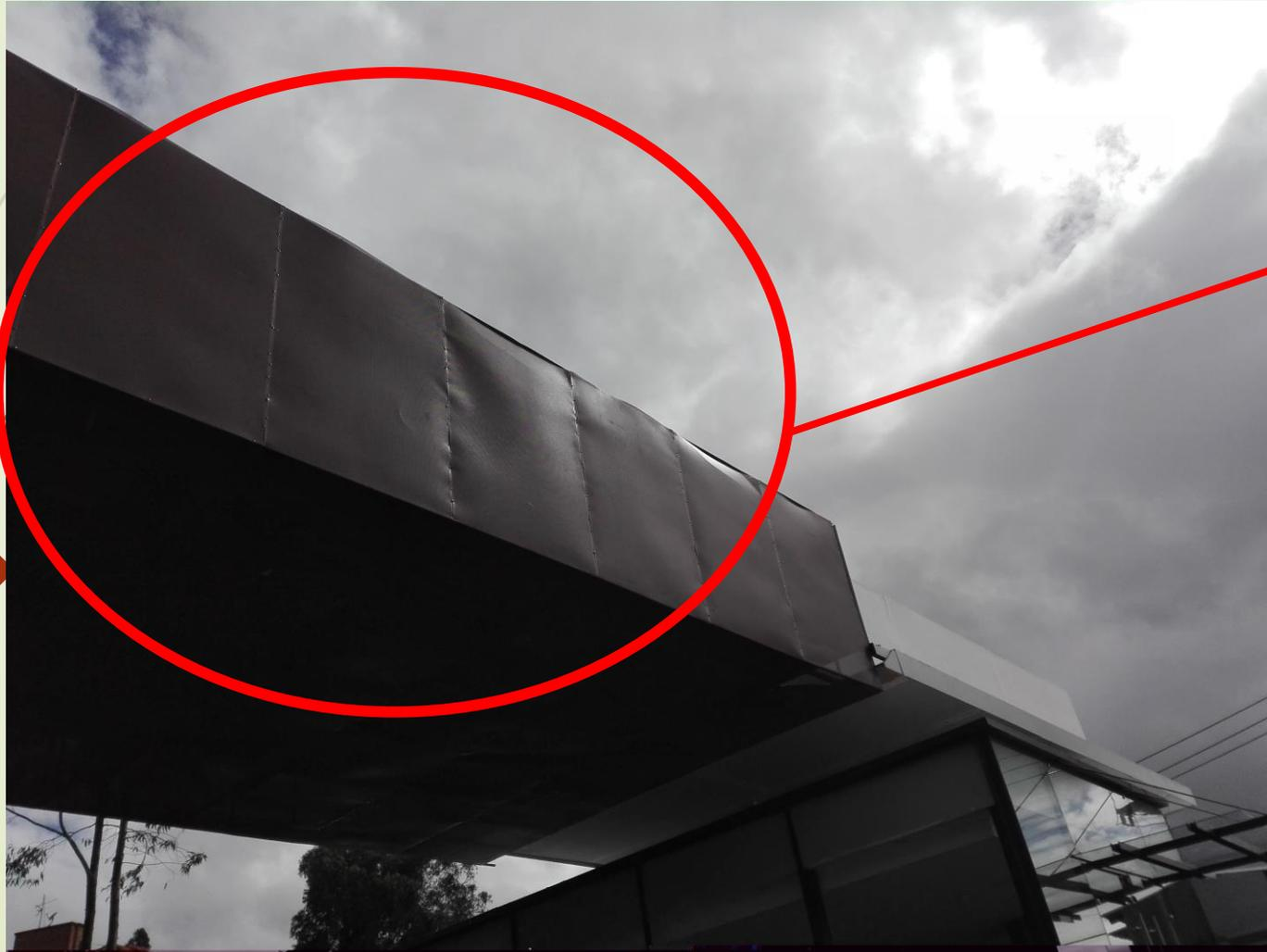
ESTADO ACTUAL DE LAS LAMINAS MICROPERFORADAS, GOLPEADAS, DESALINEADAS CON HENDIDURAS Y MANCHAS.
