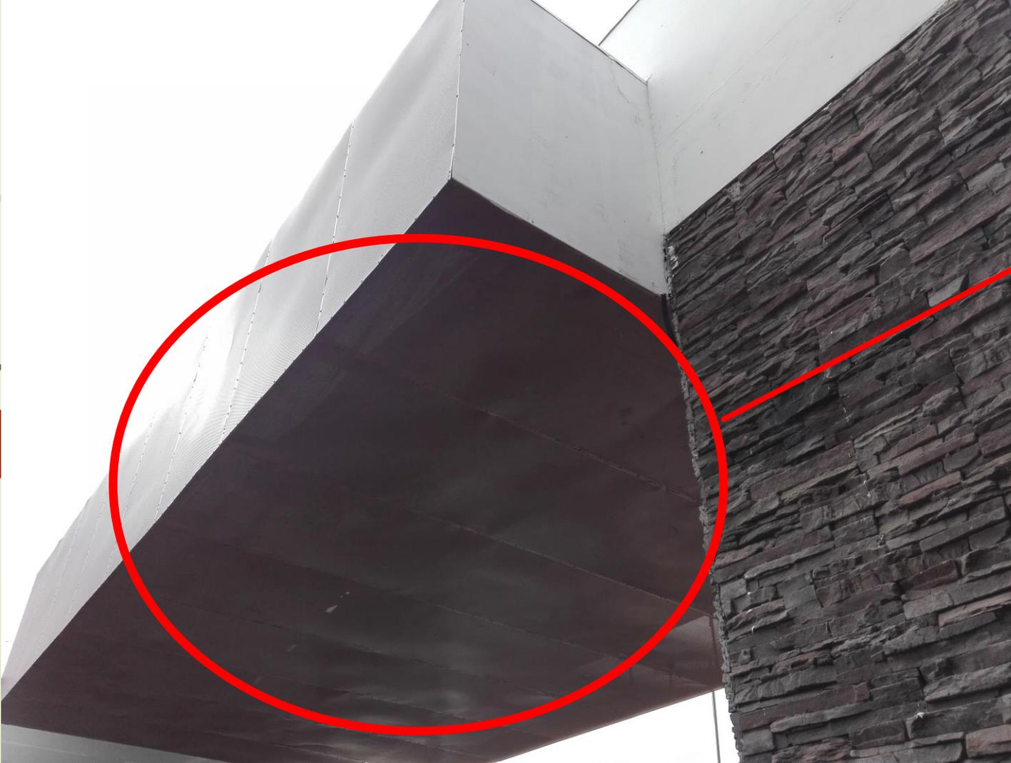
ESTADO ACTUAL DE LAS LAMINAS MICROPERFORADAS, GOLPEADAS, DESALINEADAS CON HENDIDURAS.
