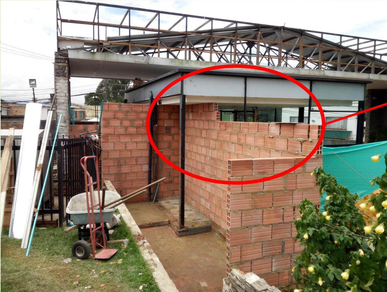
MUROS CONSTRUIDOS SIN COLUMNETAS DE CONFINAMIENTO, NI VIGAS DE CIMENTACION, COMO TAMPOCO VIGAS DE REMATE EN LA PARTE SUPERIOR
