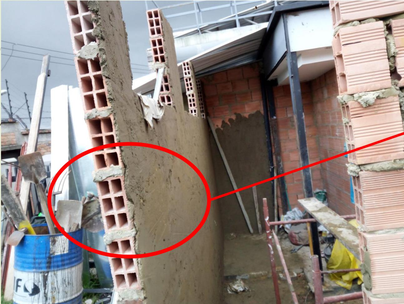
MUROS SUELTOS, NO SE EVIDENCIA COLUMNETAS DE SOPORTE, SIN NORMATIVIDAD PARA ELEMENTOS NO ESTRUCTURALES
