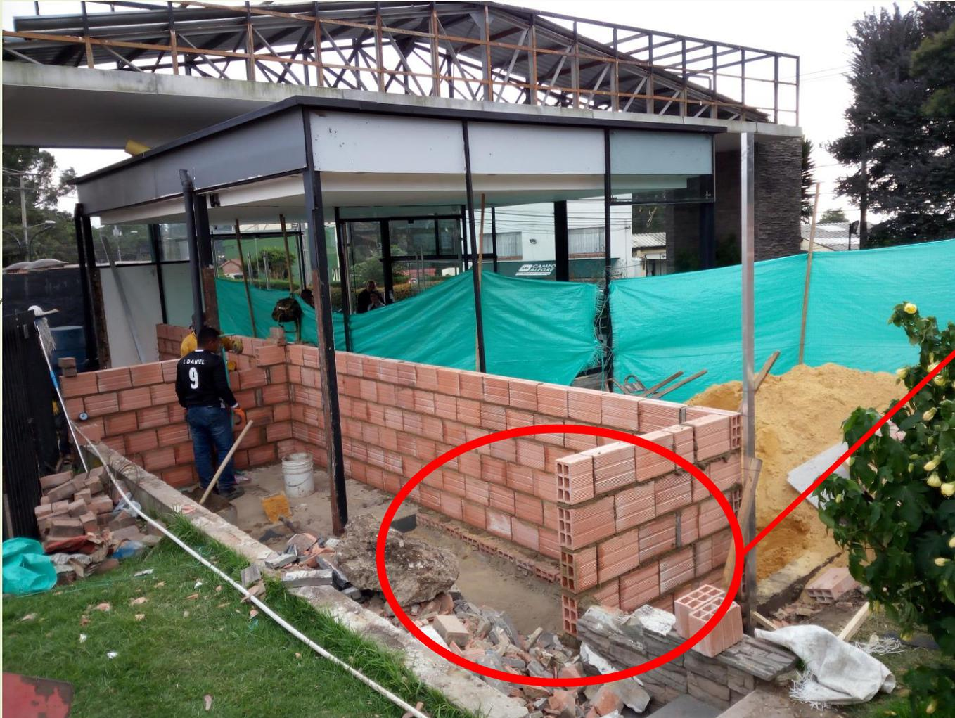
MUROS CON CIMENTACION EN BLOQUE, SIN VIGA DE AMARRE, NO SE EVIDENCIA COLUMNETAS DE SOPORTE
