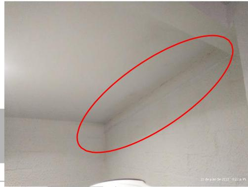
Se evidencia presencia de manchas por humedad, situado en el muro de cocina y baño, se evidencia en el techo fisuras y dilataciones el cual no competen a daños por cubierta.
