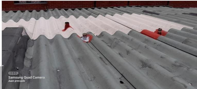
En el proceso de instalación de las tejas se evidencia como quedo el estado actual de la instalación de las nuevas tejas con el sistema de estampillado, y el proceso de limpieza, mantenimiento e instalación de sistema anti palomas, esto con el fin de dar cumplimiento a lo contratado son el conjunto, se realiza el sello de los ductos de desfogue de ventilación como valor agregado en el contrato para dar cumplimiento en su totalidad.
