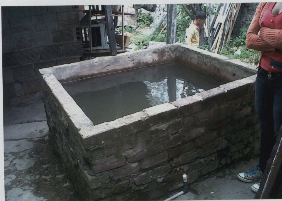
FOTO No 34 ALBERCA PARA ALMACENAMIENTO DE AGUA EN PATIO INTERNO
