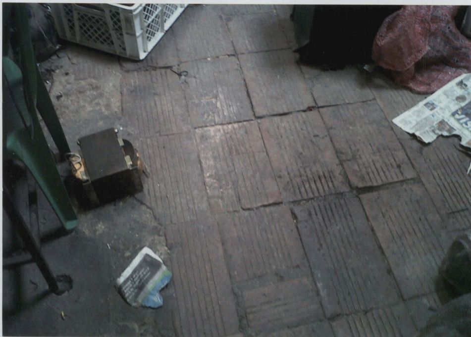
FOTO No 20 ACABADO DE PISOS EN BLOQUE DE ARCILLA
