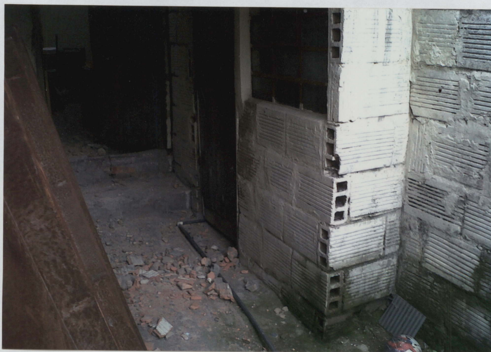
FOTO No 21 ACABADO DE PISOS EN MORTERO
