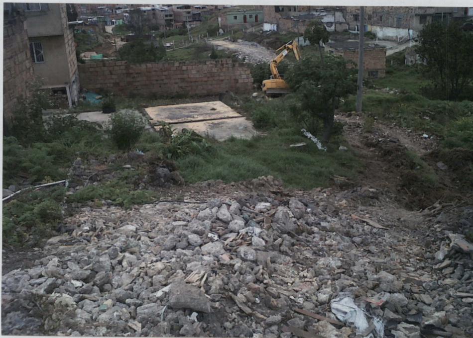
FOTO No 9 POR EL ORIENTE CON ZONA VERDE DE LA QUEBRADA SANTA LIBRADA
