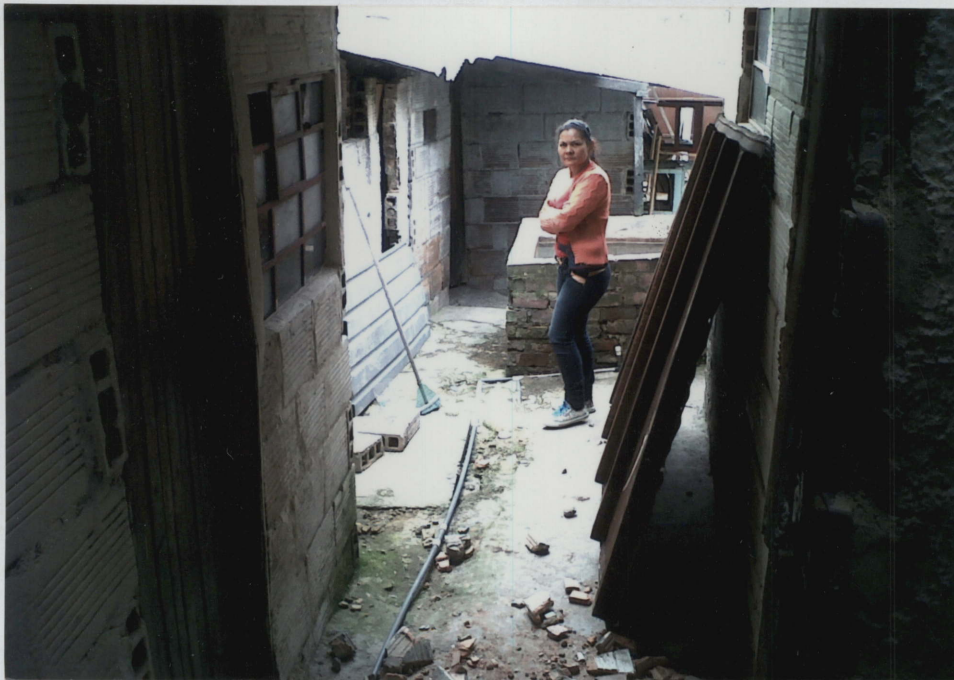
FOTO No 29 PATIO INTERNO PISO EN MORTERO NO AFINADO
