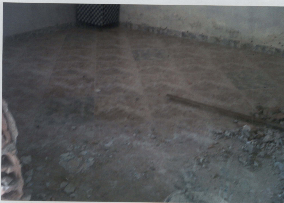
FOTO No 19 ACABADO DE PISOS EN CERAMICA
