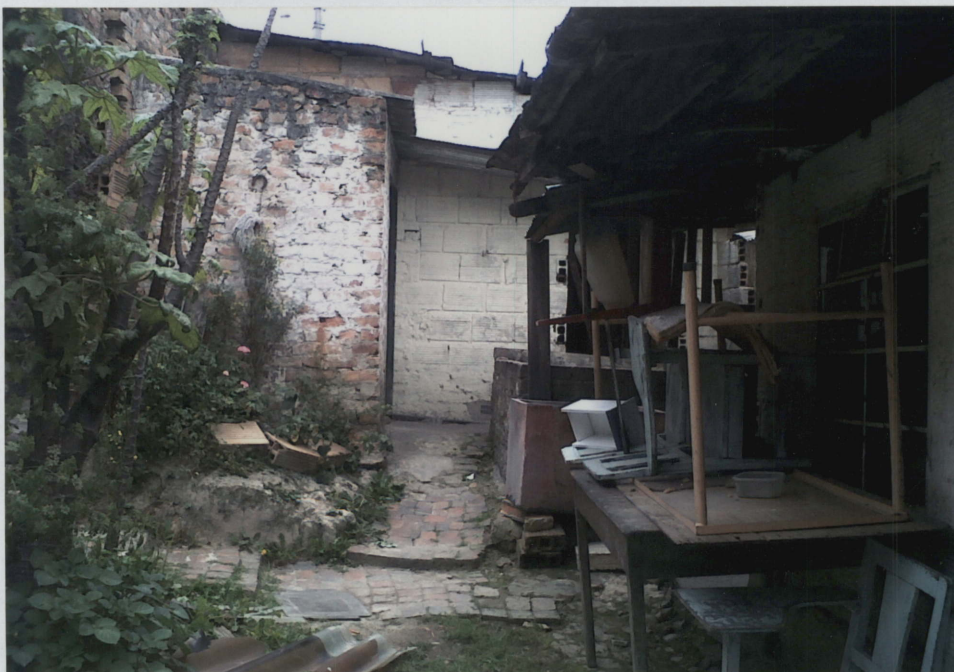
FOTO No 30 PATIO INTERNO CON PISO EN LADRILLO TOLETE
