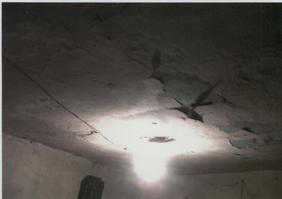
FOTO No 26 ACABADO CIELO RASO EN ESTUCO Y PINTURA
