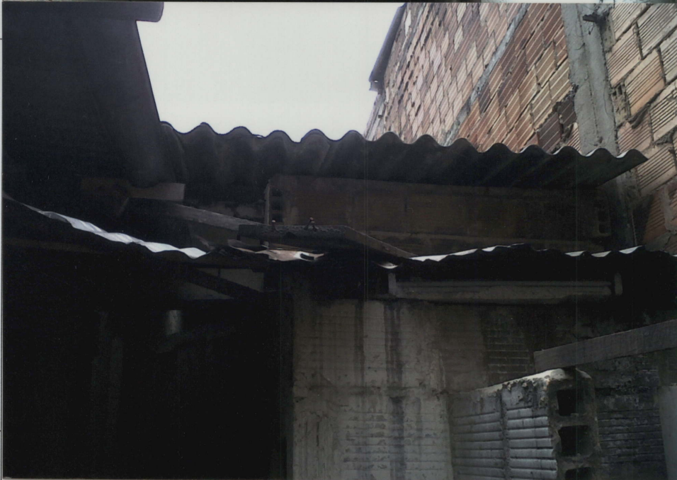
FOTO No 24 CUBIERTA EN LAMINA DE ACESCO
