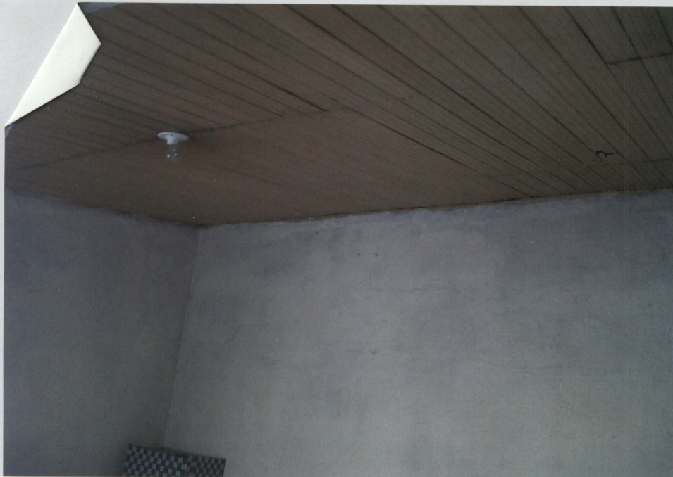
FOTO No 25 ACABADO CIELO RASO EN MADERA
