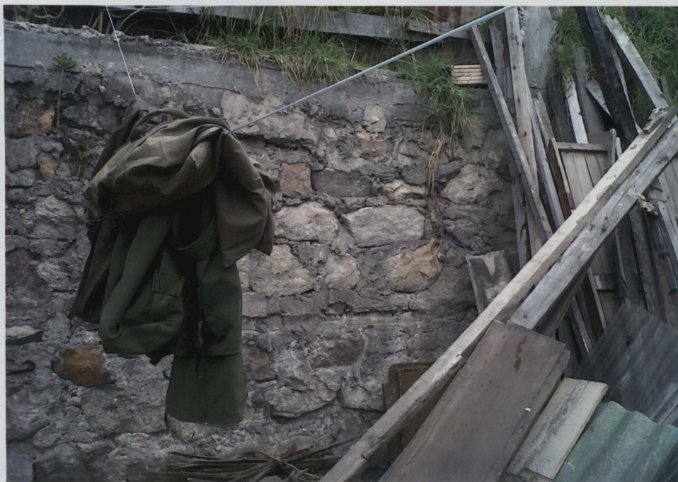
MURO EN PIEDRA COSTADO SUR ORIENTAL EN PATIO INTERNO
