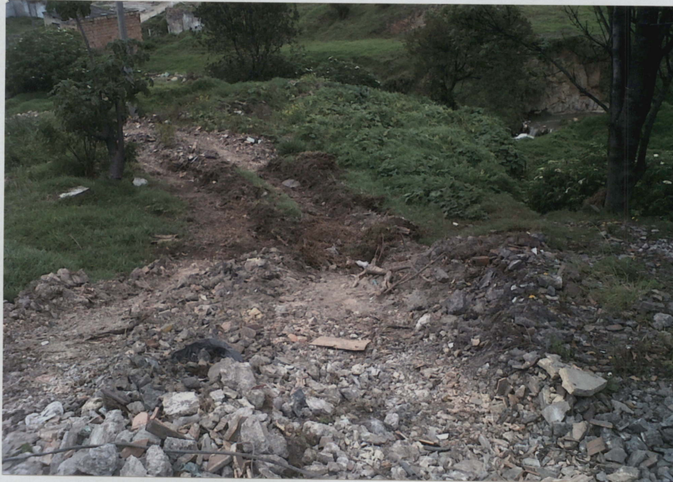
FOTO No 8 POR EL ORIENTE CON ZONA VERDE, DE LA QUEBRADA SANTA LIBRADA
