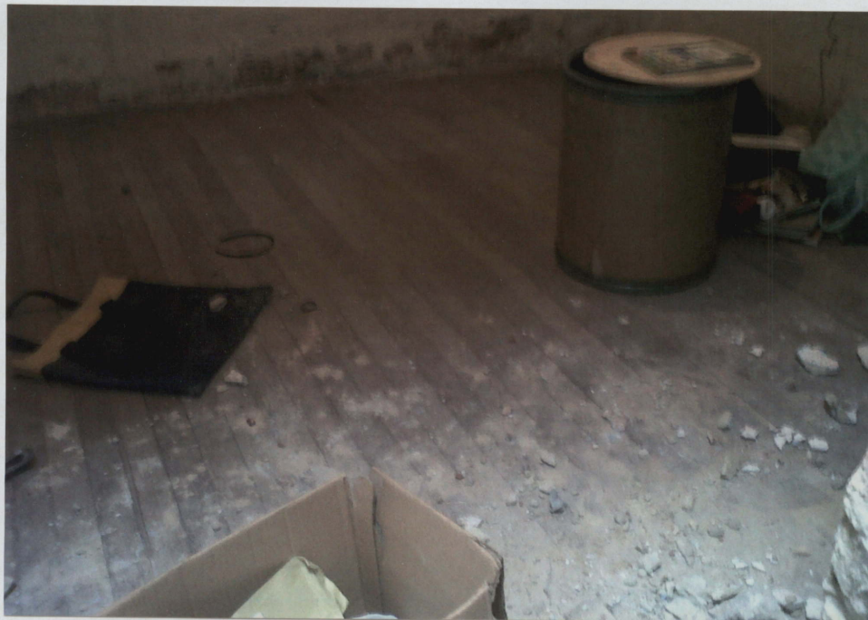
FOTO No 18 ACABADO PISOS MADERA
