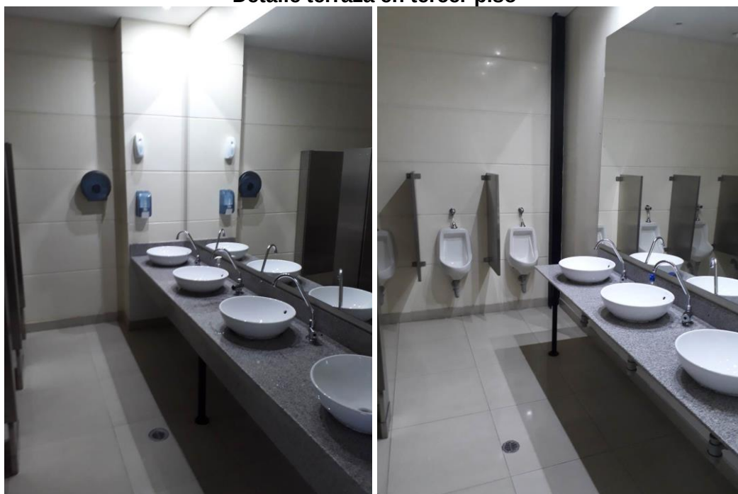
Detalle interior batería de baños
