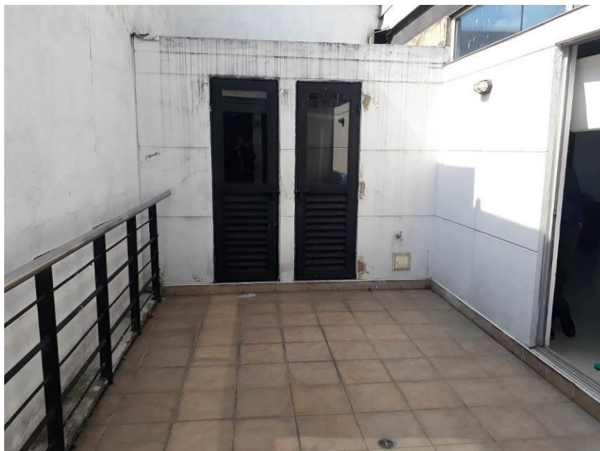
Detalle terraza en tercer piso
