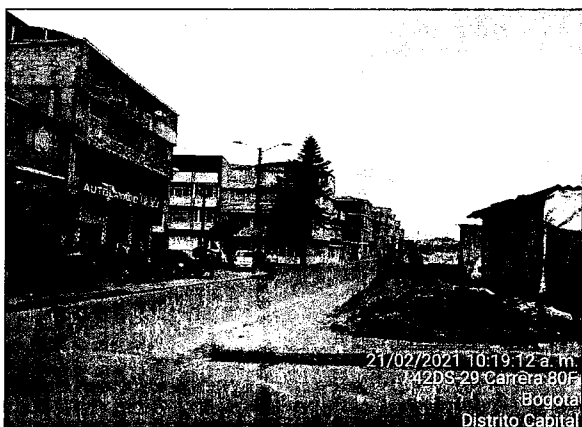
Aspecto E-W de la Calle 42F Bis S
