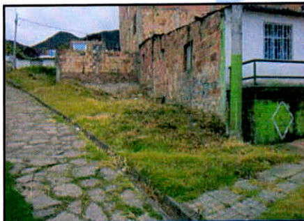
Ilustración 8- Foto de Fachada
