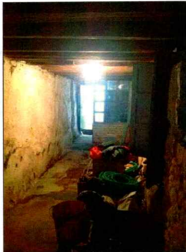
INTERIOR CONSTRUCCIÓN CA7.
