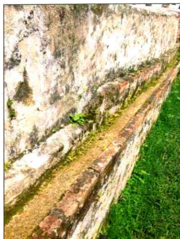
CANAL DE DESAGUE – CA14.
