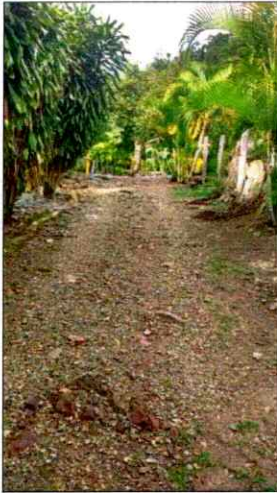
ADECUACIÓN TERRENO CON RECEBO – CA32M1.
