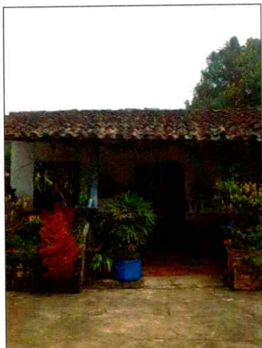
FACHADA CONSTRUCCIÓN C1.
