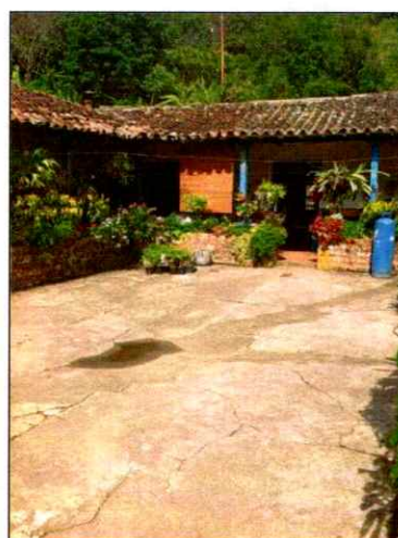
PATIO EN CONCRETO – CA5.
