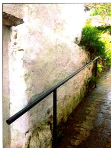
MURO DE CONTENCIÓN – CA17.
