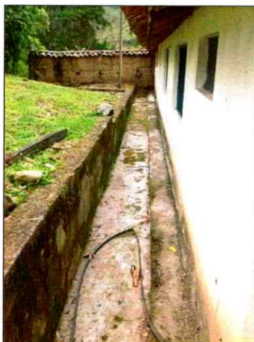
CANAL DE DESAGUE – CA21.
