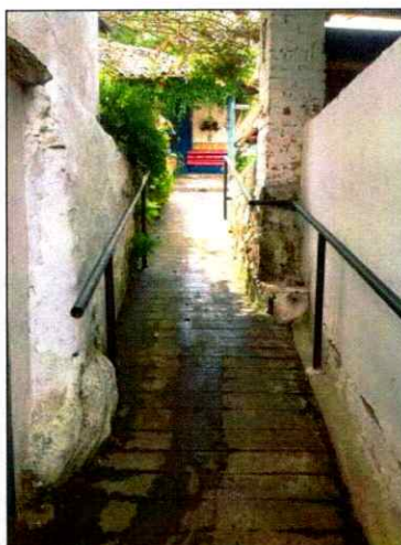
RAMPA EN CONCRETO – CA18.
