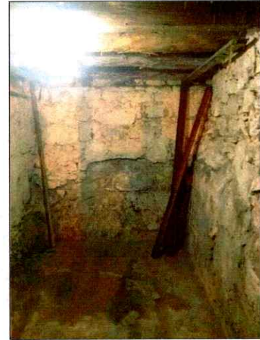
INTERIOR CONSTRUCCIÓN CA7.
