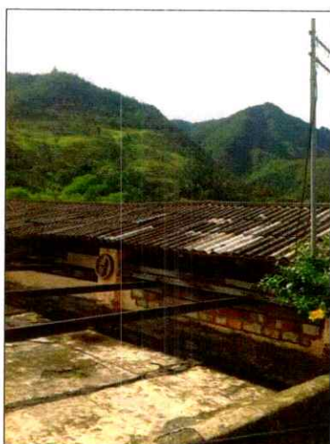
FACHADA CONSTRUCCIÓN C4.
