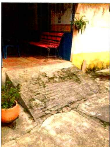
RAMPA EN CONCRETO – CA3.
