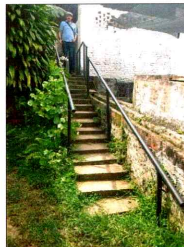
VISTA ESCALERAS – CA16.
