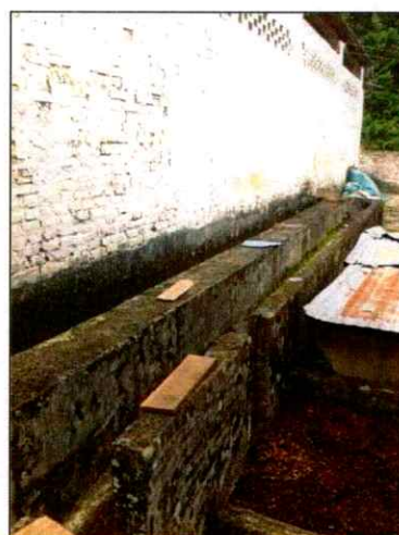
PATIO EN CONCRETO – CA13.
