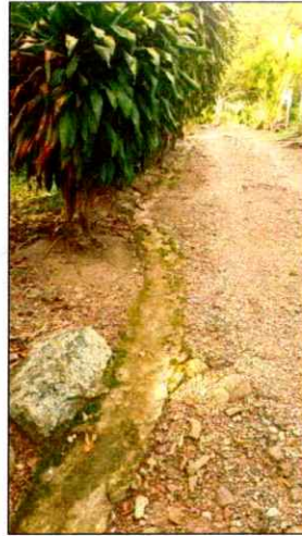
CUNETAS EN CEMENTO – CA33M1.
