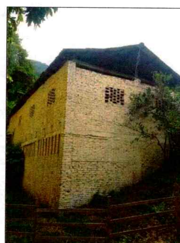
FACHADA CONSTRUCCIÓN C3.
