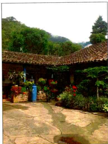
FACHADA CONSTRUCCIÓN C2.
