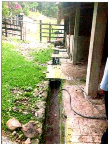
CANAL DE DESAGUE – CA20.
