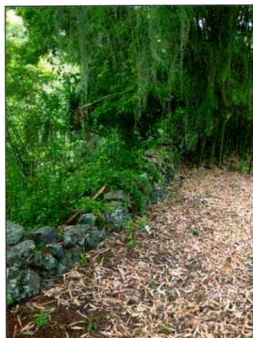
CIMIENTO EN PIEDRA – CA29.
