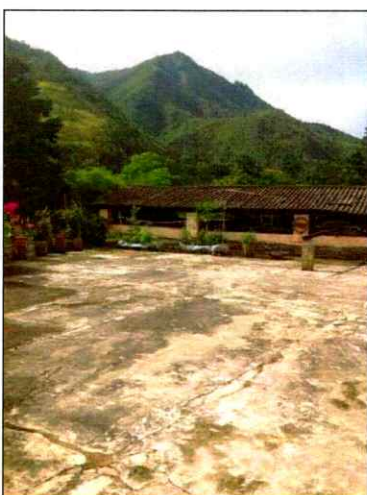
PATIO EN CONCRETO – CA4.
