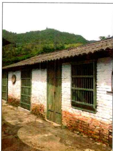
FACHADA CONSTRUCCIÓN C3.
