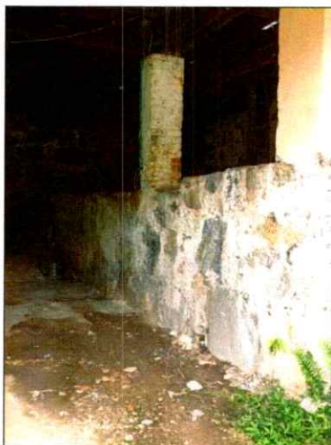
MURO DE CONTENCIÓN – CA10.
