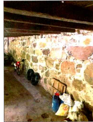
MURO DE CONTENCIÓN – CA9.
