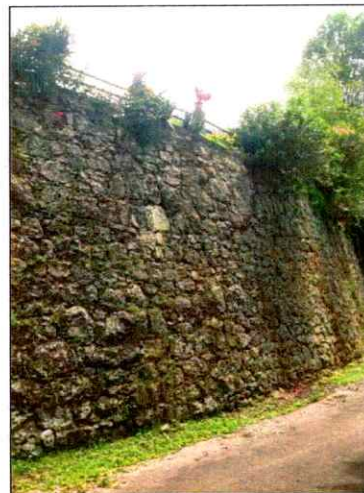
MURO DE CONTENCIÓN – CA28.
