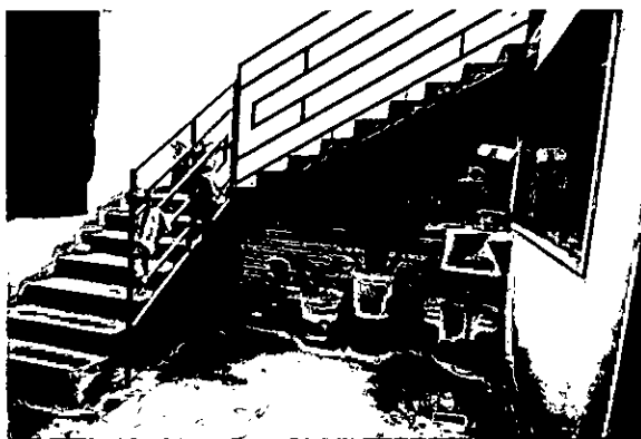
ESCALERA INTERNA DE ACCESO 2 NIVEL
