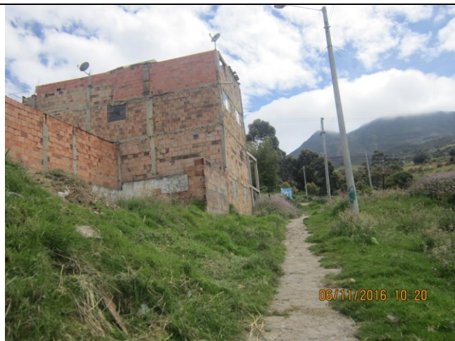
Vista del sector
