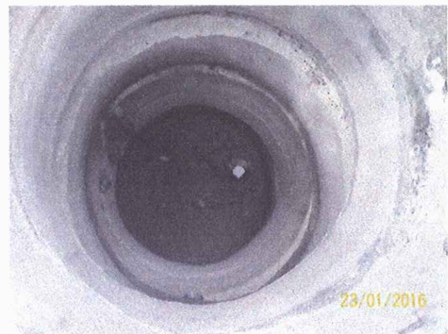
Vista de frente pozo artesanal anillado sin agua
