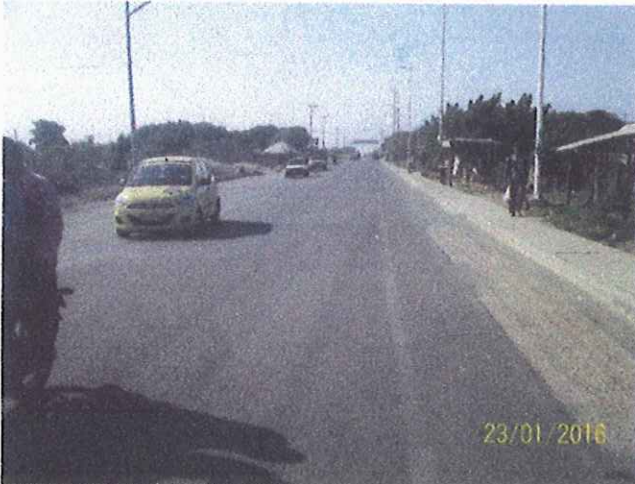
Carretera Riohacha Arroyo Arena
