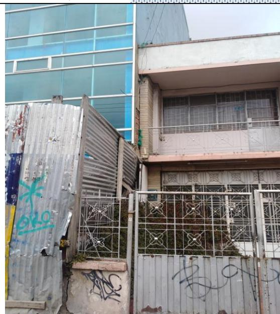
CARENCIA DE JUNTA SISMICA CON CONSTRUCCION
