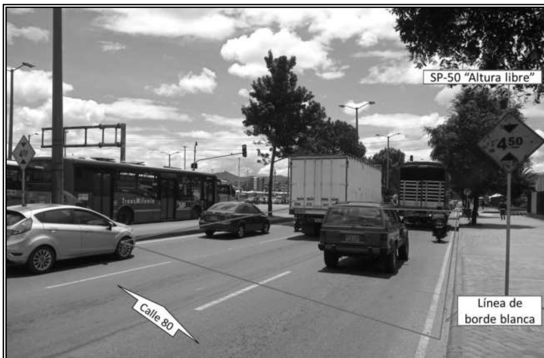
Imagen 2.3 Características de la vía
