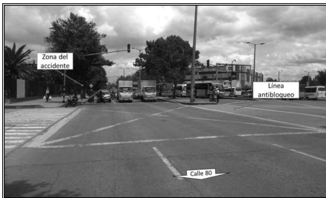
Imagen 2.5 Características de la vía
