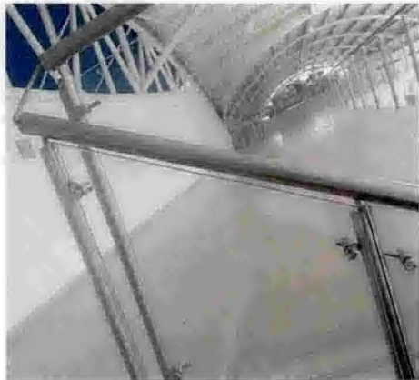
b. Estructurado con Parales y Pasamanos en Acero Inoxidable en Tubo Redondo de 2".
