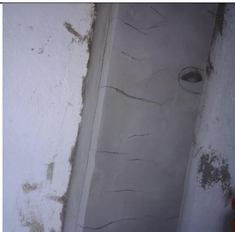
HUMEDAD Y DILATACIONES MURO
