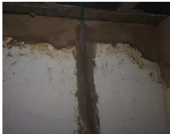
HUMEDAD Y DILATACIONES MURO
