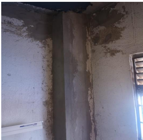
HUMEDAD COLUMNAS
