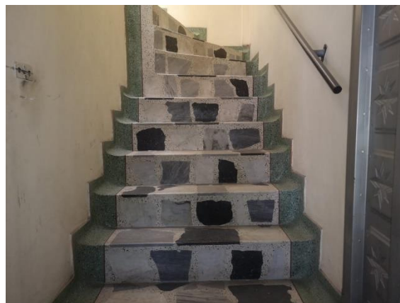
ESCALERA ACCESO TERCER PISO
