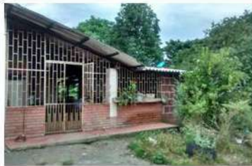
Imagen 37. Vereda Aguabuena, del municipio de Confines
