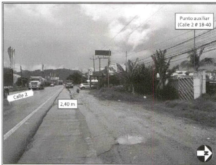
Imagen 2.7 Condiciones de la vía calle 2 sentido Oriente-Occidente.
