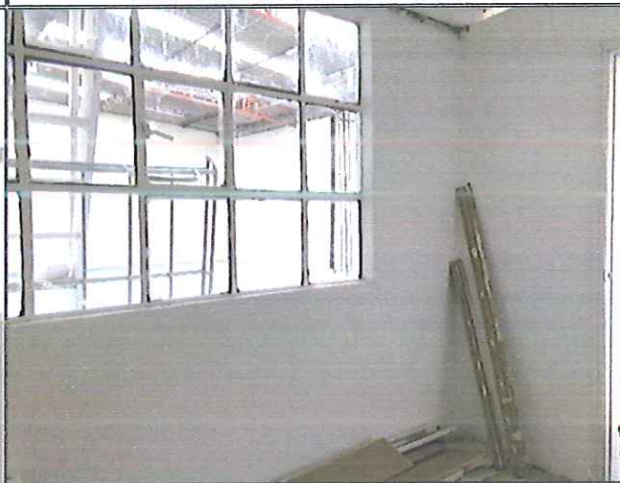
CUARTO DE DEPOSITO 1
