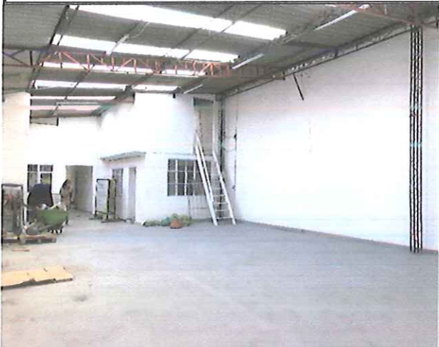
ÁREA LIBRE DE BODEGA
