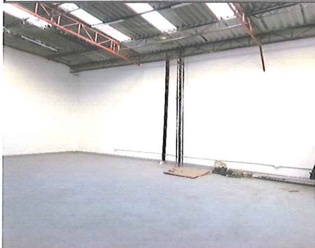
ÁREA LIBRE DE BODEGA
