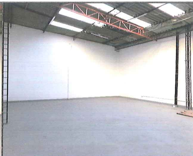
ÁREA LIBRE DE BODEGA
