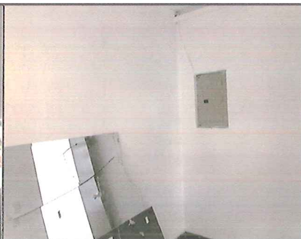
CUARTO DE DEPOSITO 2
