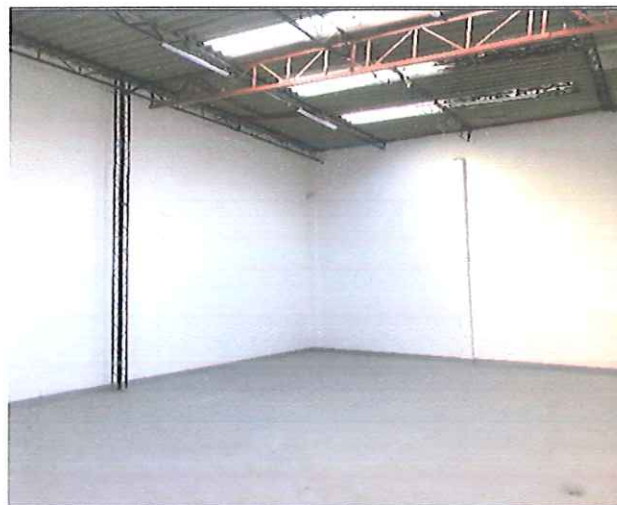
ÁREA LIBRE DE BODEGA
