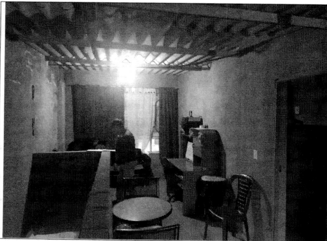
Foto No. 17 Vista general de la construcción
