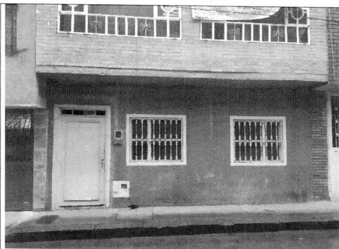
Foto No. 3 Vista de la Fachada
