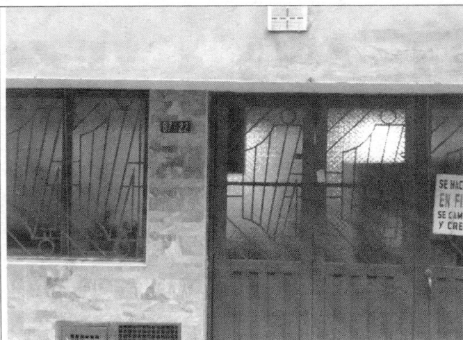
Foto No. 5 Vista del lindero Norte 871 - 22
