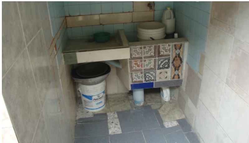
LAVADERO DEL PRIMER PISO
