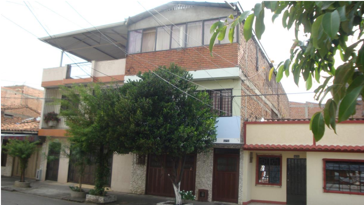
FACHADA DEL PREDIO URBANO DE TRES PISOS, DETERMINADO CON LA PLACA No. 32A-53 DE LA CALLE 14C DEL BARRIO CRISTOBAL COLÓN DE CALI (V.).
