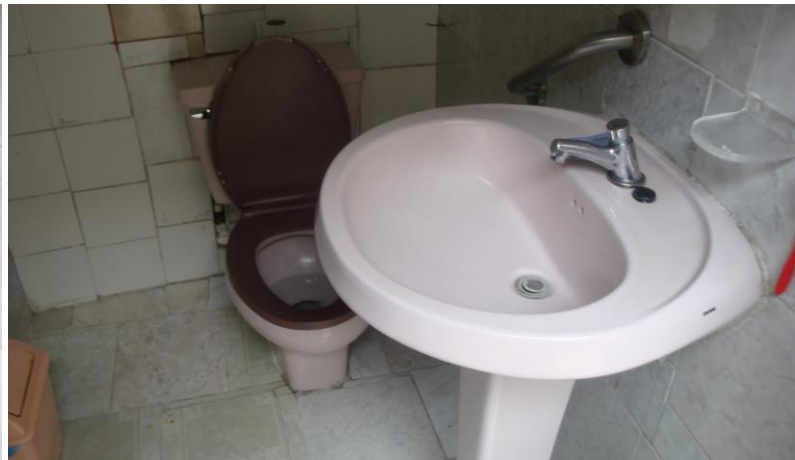
BAÑO COMPLETO DEL PRIMER PISO
