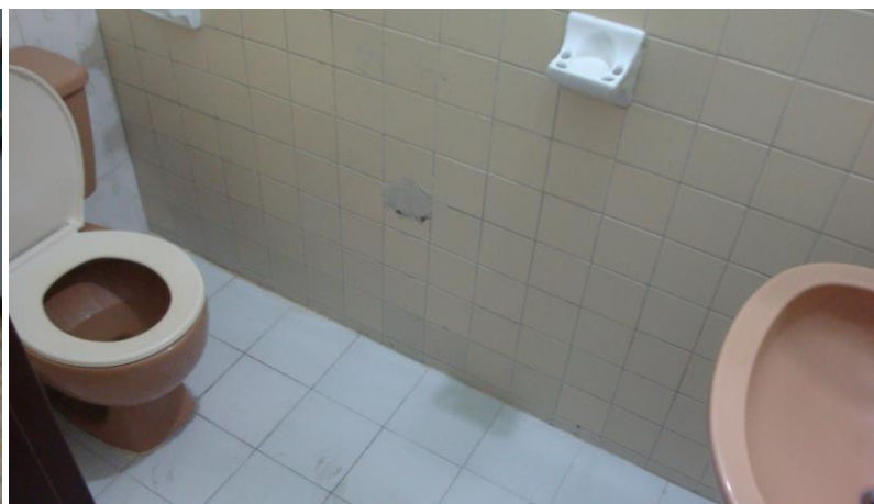
BAÑO SOCIAL DEBAJO DE GRADAS DEL PRIMER PISO
