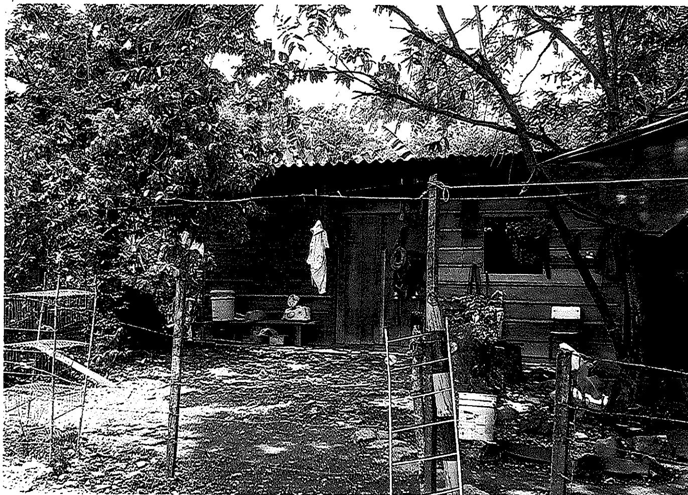
FACHADA DE LA MEDIDA EN MADERA
