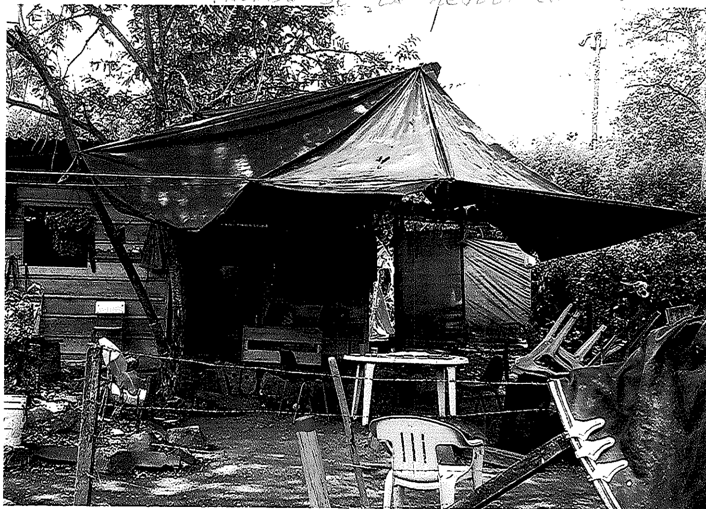
FACHADA DE LA MEDIDA EN MADERA
