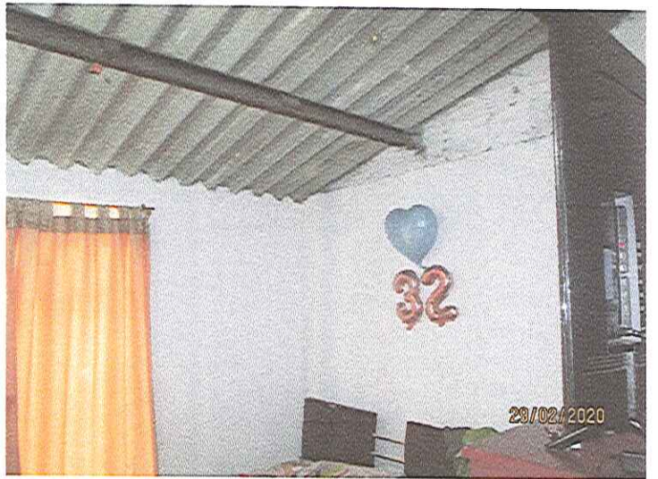
INTERIOR DEL INMUEBLE
