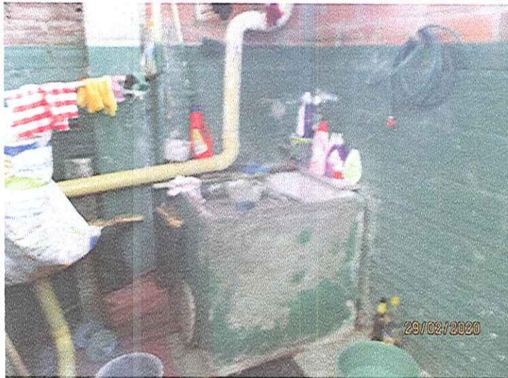
INTERIOR DEL INMUEBLE
