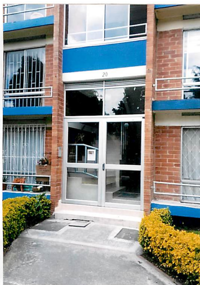
PUERTA DE ENTRADA AL INTERIOR 20
