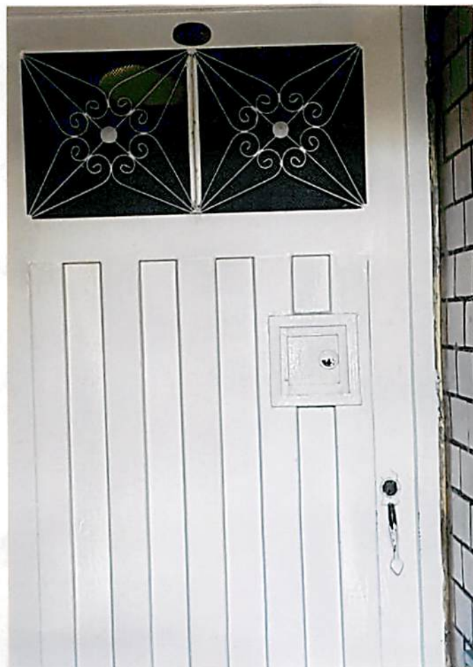
PUERTA ENTRADA AL APARTAMENTO 102
