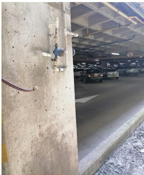
Aquí se puede percibir el tapón blanco que le instalo a la tubería que proporcionaba el fluido del agua
