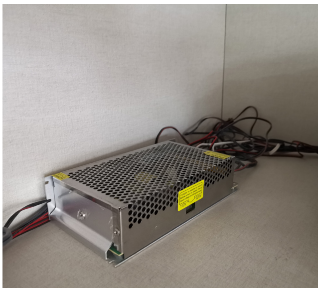
Imagen 10 ▲ Elementos al interior del closet
