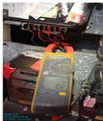
Foto No 2 : Servicio reconectado, Medidor sin tapa de conexiones
