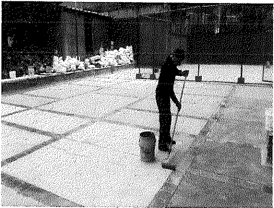
Aplicación de PVA, fijamix y cemento
