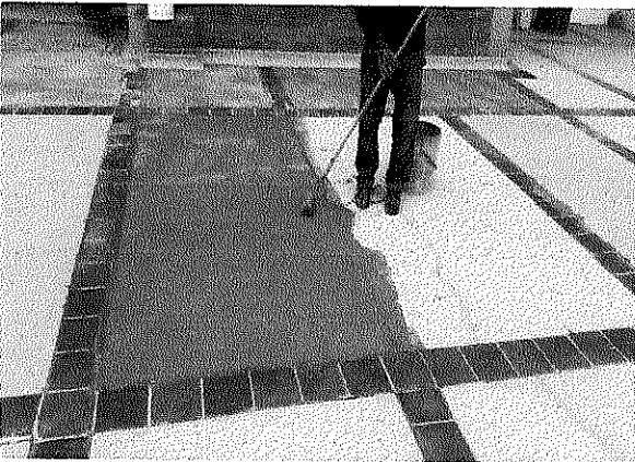
Aplicación de PVA, fijamix y cemento
