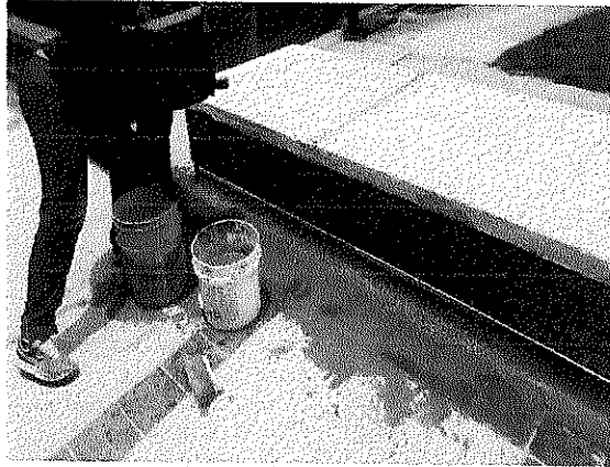
Instalación de granito
