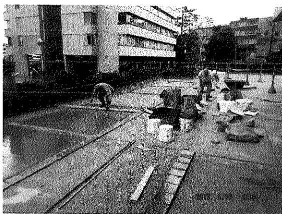
Instalación de Sikalisto piso y tablón.
