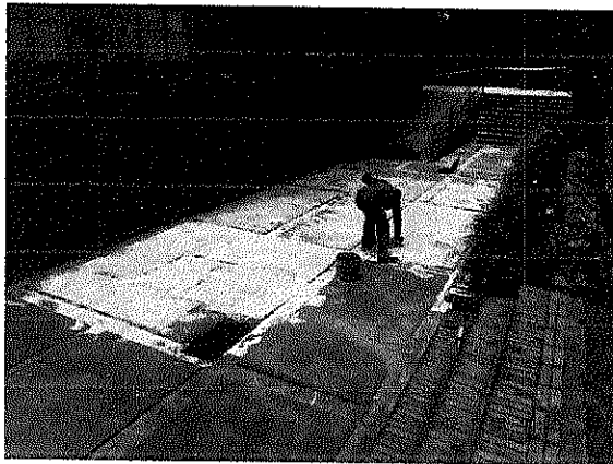
Instalación de 2km y tela poliéster
