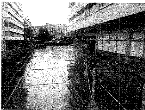
2km Prueba de agua torre B
