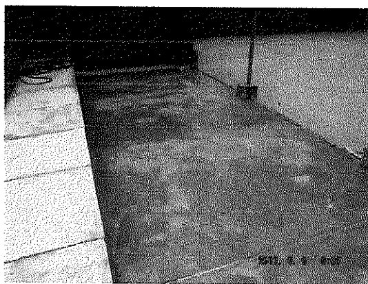
Aplicación de 2km impermeabilizante.
