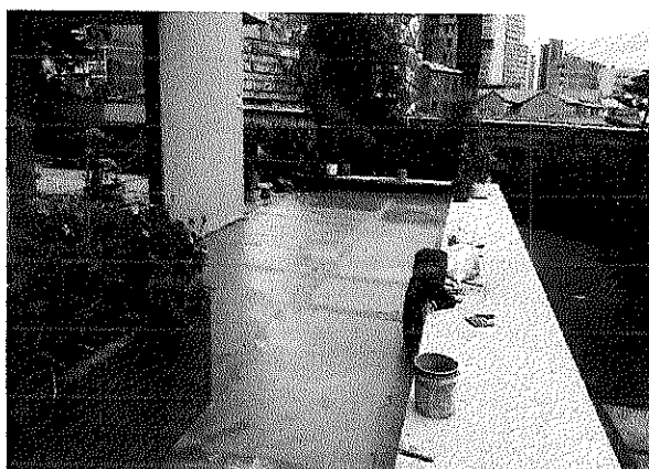
Instalación Sikalisto piso y tablón.
