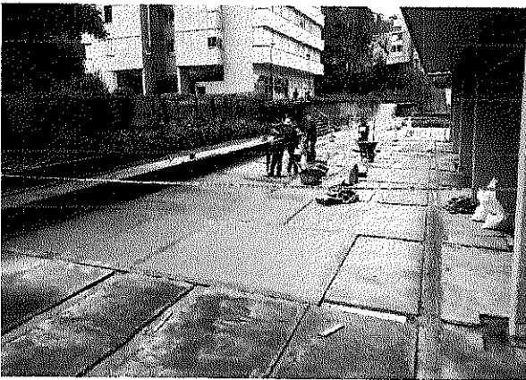
Instalación Sikalisto piso
