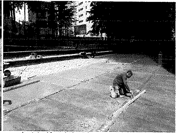
Instalación tablón Cúcuta y Sikalisto piso
