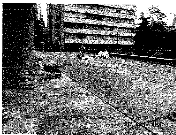
Instalación Sikalisto piso
