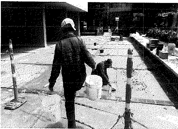
Instalación de tablón Cúcuta.
