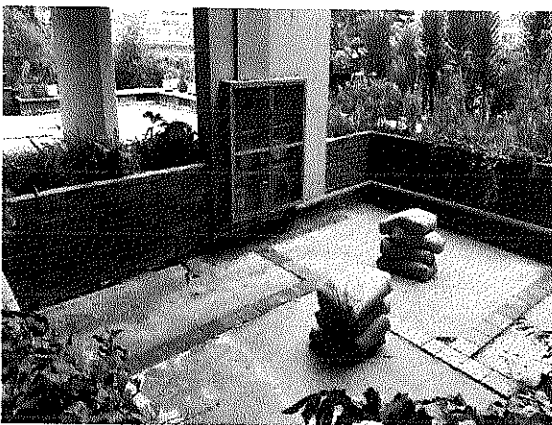
Instalación tablón y Sikalisto piso.
