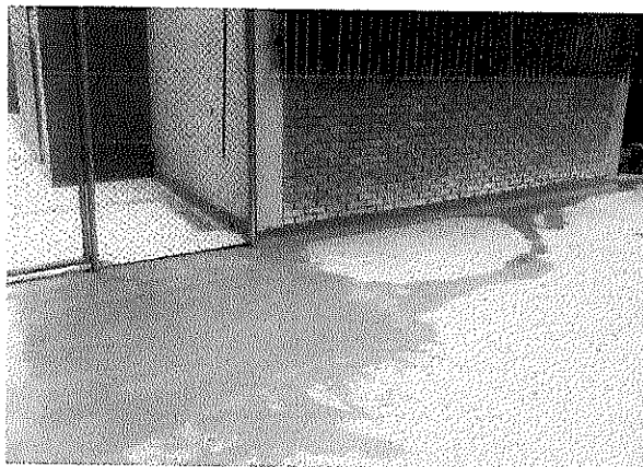
Nivelación de piso cancha de tennis
