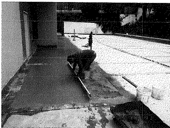
Instalación Sikalisto piso Torre B costado sur
