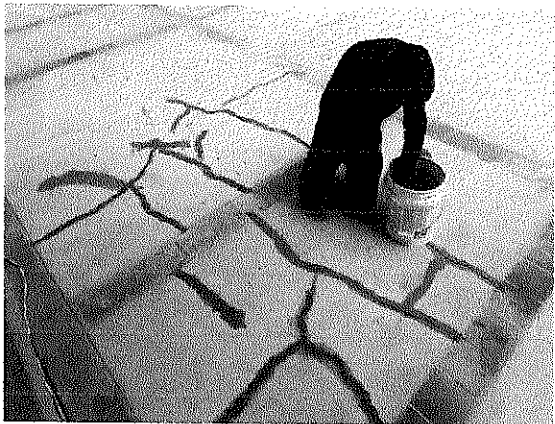
Tratamiento de Fisuras
