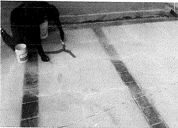
Tratamiento de Fisuras
