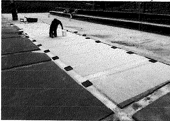
Instalación de 2km y tela poliéster
