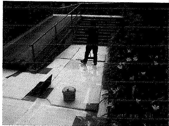
Instalación de 2km y tela poliéster
