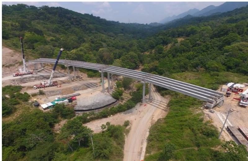
*Fotografía 2 Vista general del puente Viaducto 1 con la totalidad de vigas izadas”*
