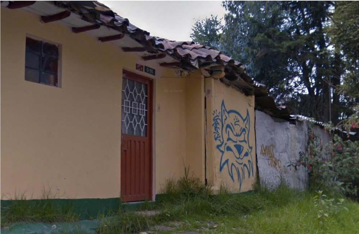
No. 3.- Foto satelital de 2018, nos muestra el deterioro del alero, sobre la fachada del costado norte de la edificación de la Calle 12F No. 0-05
