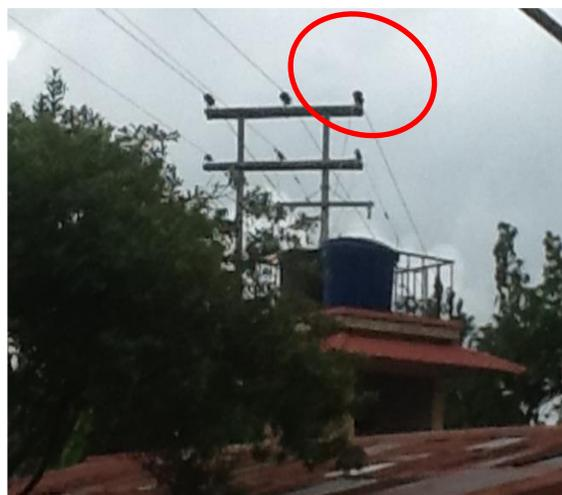
Se observa que los cables afectados corresponden solamente a una de las fases del circuito Liberia y no a toda la red presente en el sitio.
