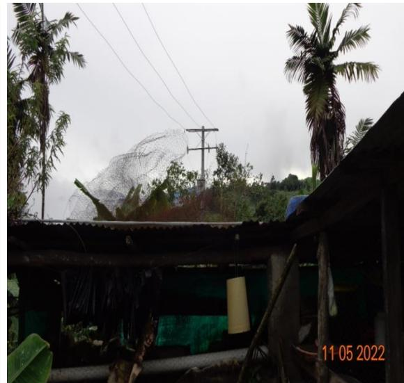
En la finca EL PORVENIR se encuentra una estructura en media tensión de doble nivel con un circuito a 34.5 Kilovoltios denominado **LIBERIA** y otro a 13,2 Kilovoltios denominado **PIN**, instalados en dos (2) postes de concreto de 14 metros de longitud, con altura libre de 12 metros.
