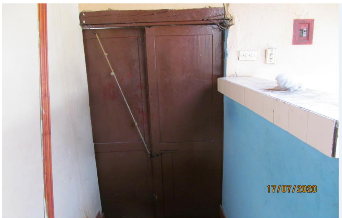
Estado inicial de los muros, donde nuevamente no se aprecian fisuras, fracturas o grietas en el acabado de los mismos.
