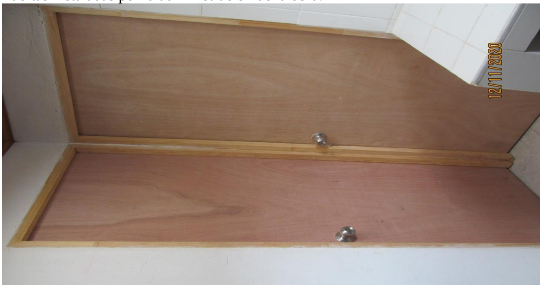
Puertas instaladas por la administración de la obra.
