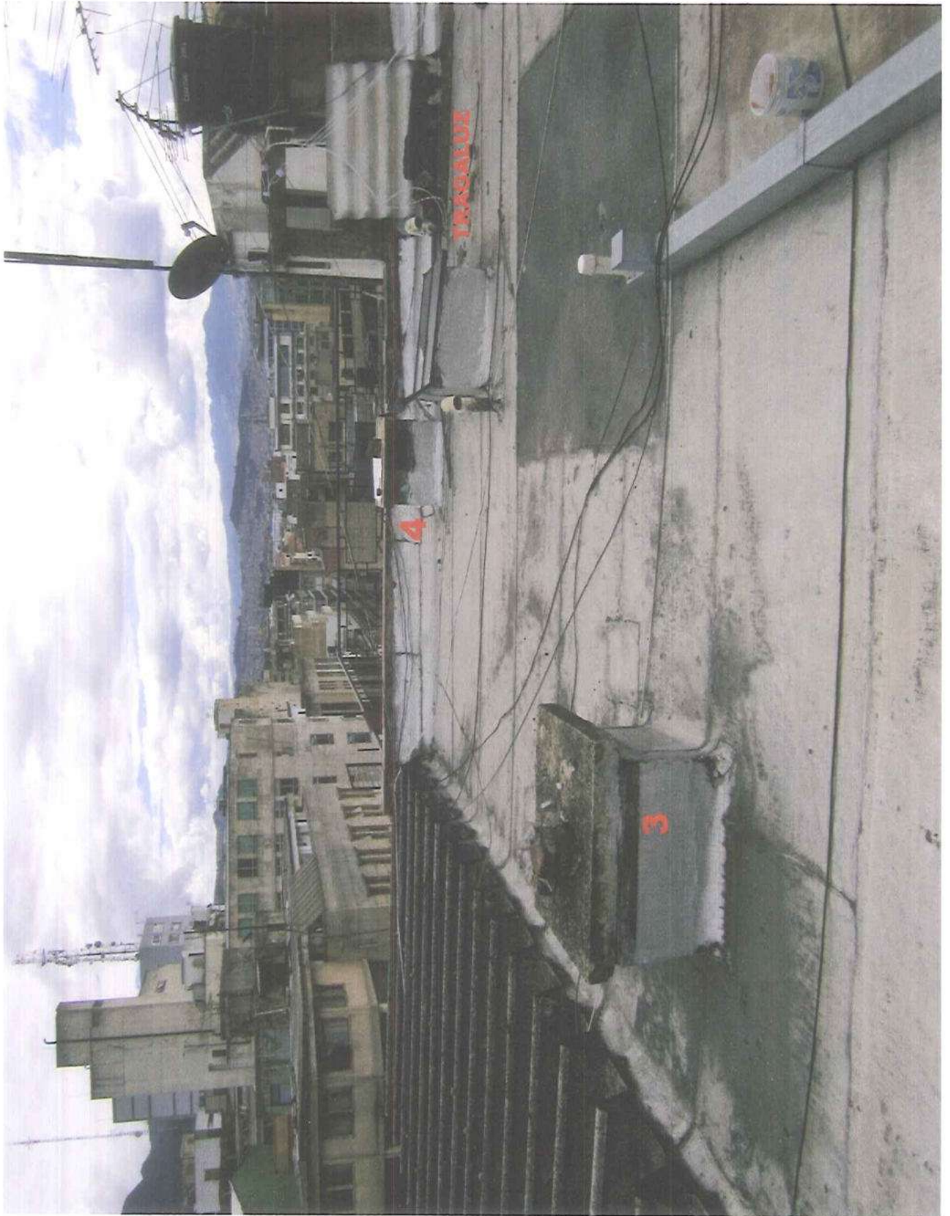
FOTOGRAFIA DE AREA COMUN Y TERMINAL DE DUCTOS EN LA TERRAZA ESTOS DUCTOS CORRESPONDEN A LOS UBICADOS Y NUMERADOS CONVENCIONALMENTE COMO: 3 Y 4 EN LA PLANTA DEL PISO 9º DEL PLANO DE P.H. DEL 6 ABRIL 1973 – LOS DUCTOS Nos 1-2-3-5 Y 6 SE MUESTRAN EN OTRA FOTO. SE OBSERVA TRAGALUZ QUE FIGURA EN LOS PLANOS CON LINEA PUNTEADA EN BAÑO DEL APTO 902 PLANOS ARQUITECTONICOS Y DE P.H. TOMADOS Y AUTENTICADOS EN LA SECRETARIA DISTRITAL DE PLANEACION - ARCHIVO DISTRITAL DE PREDIOS EL DIA 10 DE AGOSTO DE 2015
