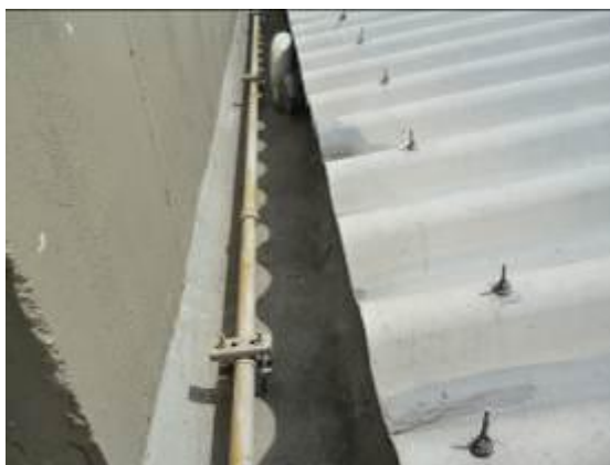
Vacío oriente. Reparaciones de tejas frente al vacío ya deterioradas; en el corto plazo la fisura quedará expuesta trayendo consigo filtraciones de agua.
