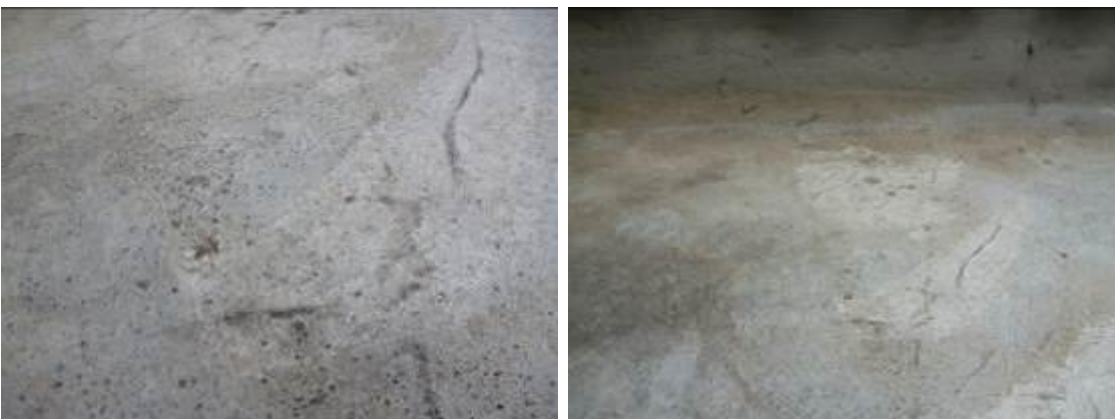
Detalle típico de placa torre 1 costado norte. Impermeabilización de placa sobre hendiduras y rugosidades
