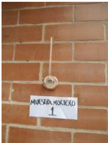
Detalle de muestra 1 mortero fachada principal torre 1
