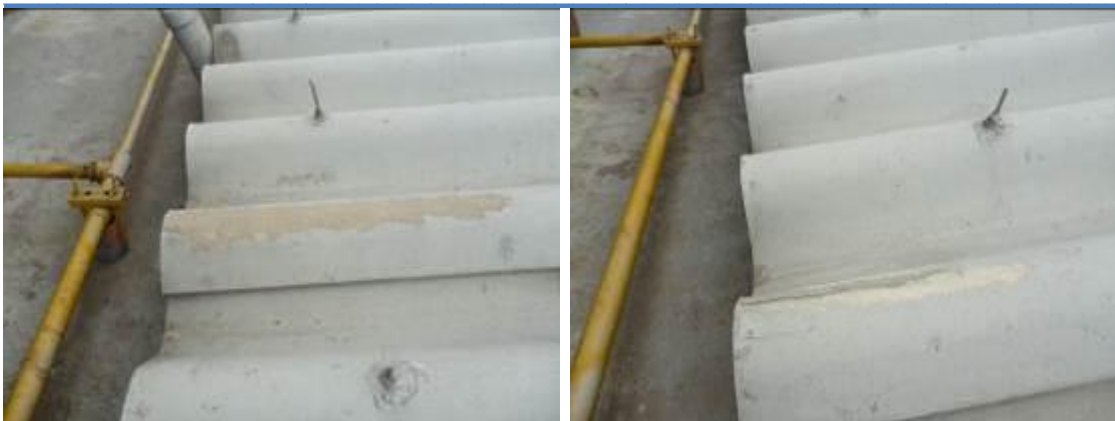
Detalles de las tejas rotas ubicadas frente a los medidores de gas torre 1.
