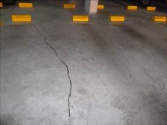
Fisuras existentes junto al parqueadero 73
