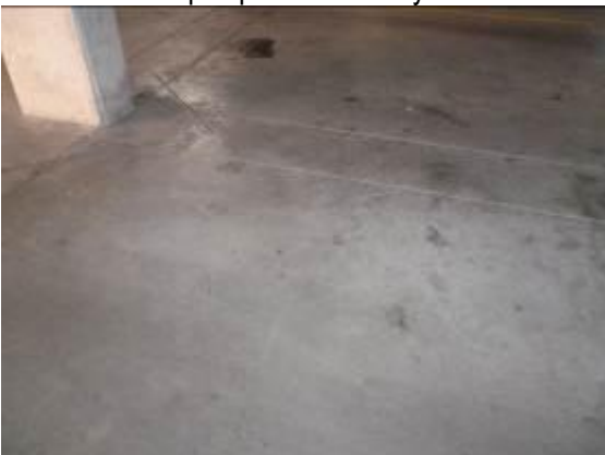
Fisuras existentes adyacentes al parqueadero 117
