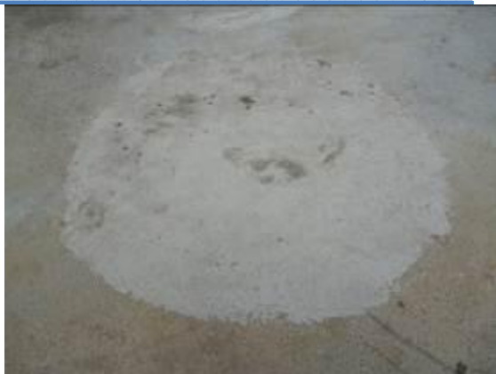
Costado sur torre 1
