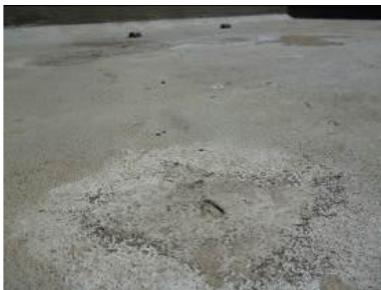
Loza plana adyacente al vacío occidente de la torre .Reparación fallada.
