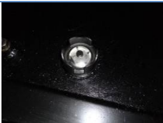
El medidor de combustible de la planta muestra que está vacío.
