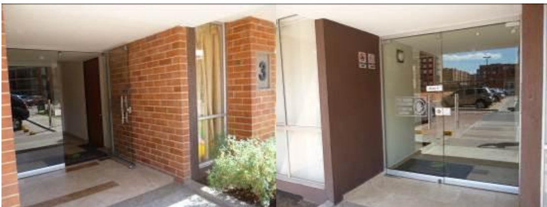
No fue suministrada la señalización de la puerta de acceso a la torre 3
