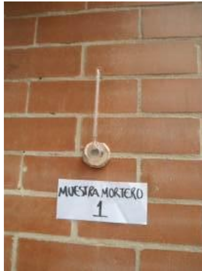
Detalle de muestra 1 mortero fachada principal torre 1
