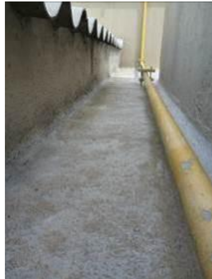
Costado norte del vacío torre 3. Especialmente en la media caña se observa demasiada rugosidad en la superficie sobre la cual se aplicó la impermeabilización.
