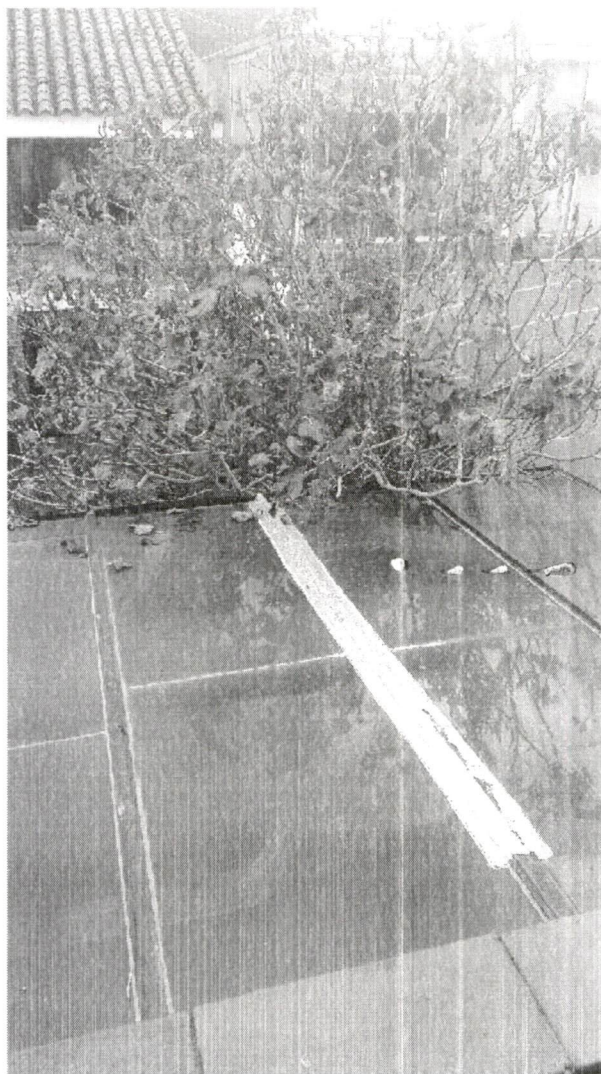
FOTO No 1 Arreglo por filtración de agua, con manto asfaltico con foil de aluminio Marquesina Apto. 102
