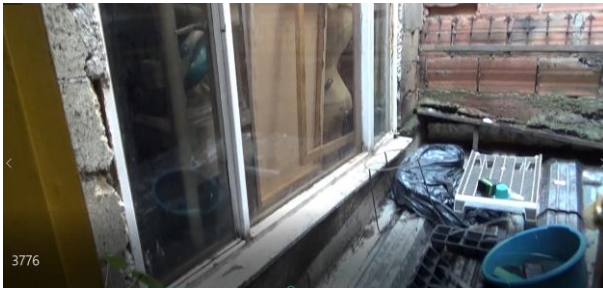
Cubierta sobre patio de ropas del apto 101 calle 105C Bis # 103F-27
