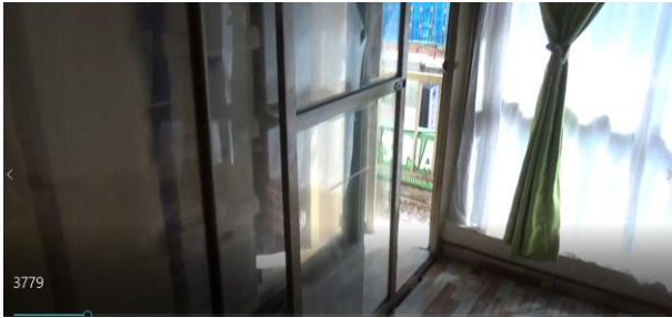
Acceso cuarto 2 , vista al frente del edificio
