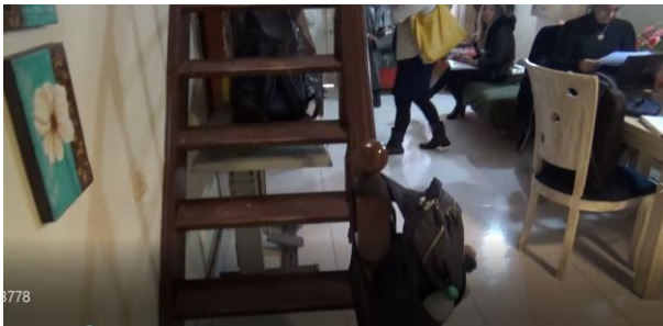
Escalera en madera para acceso al segundo piso apto 201 calle 105C Bis # 103F-27 (Tercer piso)
