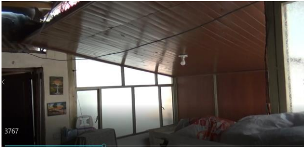
Baño y área techada y cerrada donde es placa de segundo piso.
