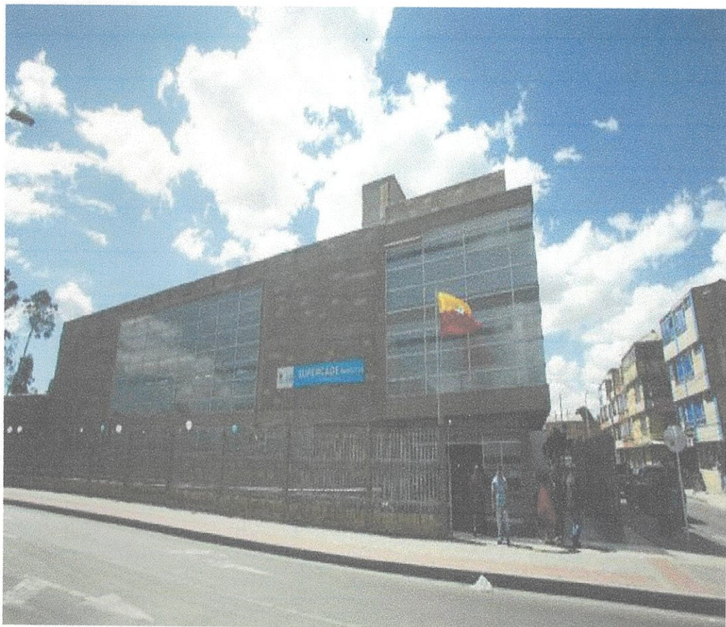
SUPER CADE ENGATIVA Avenida calle 63 y la Avenida calle 72.
