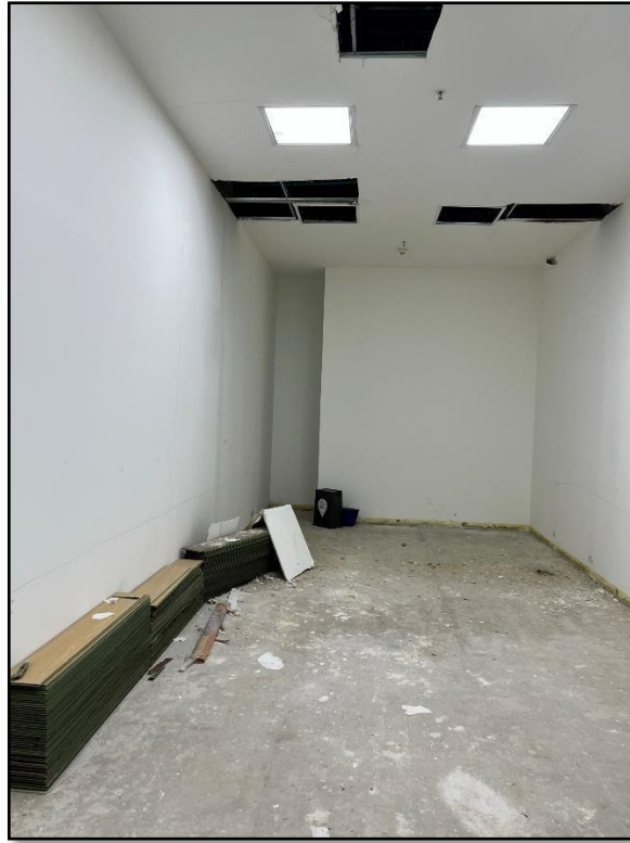
Figura 10. Fotografía del local N2-153.
