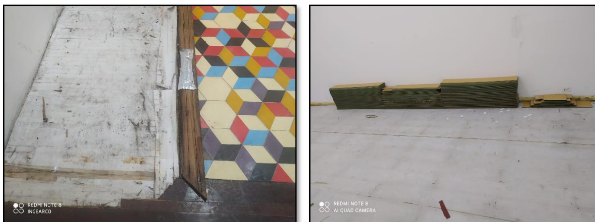
Figuras 8 y 9. Evidencia fotográfica de retiro de pisos afectados.
