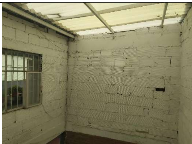
Foto No. 20 Vista general de la construcción
