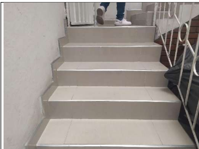
Foto No. 13 Vista general de la construcción
