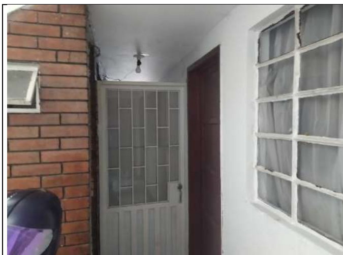
Foto No. 7 Vista general de la construcción
