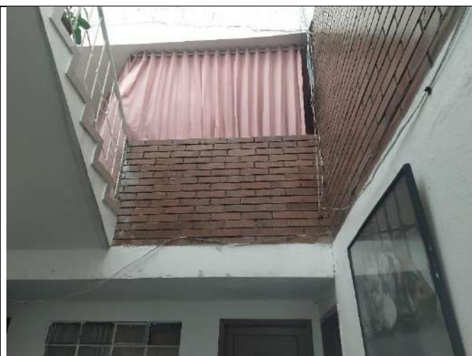
Foto No. 19 Vista general de la construcción
