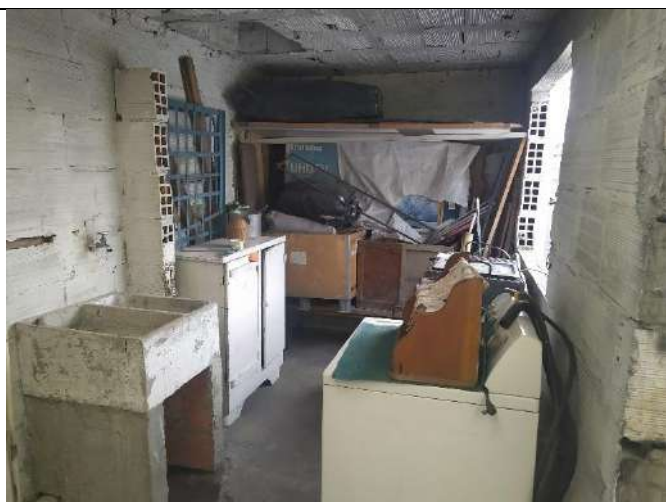
Foto No. 24 Vista general de la construcción
