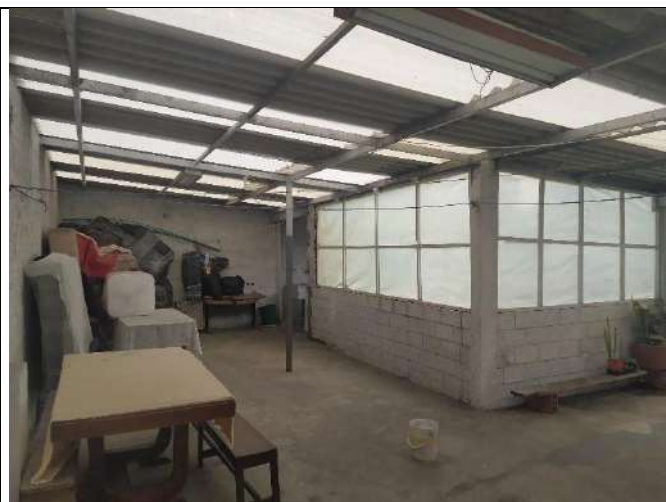
Foto No. 21 Vista general de la construcción
