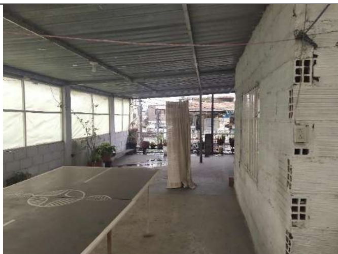
Foto No. 22 Vista general de la construcción
