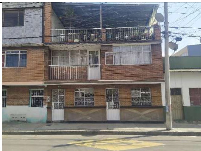
Foto No. 26 Vista general del lindero Sur
