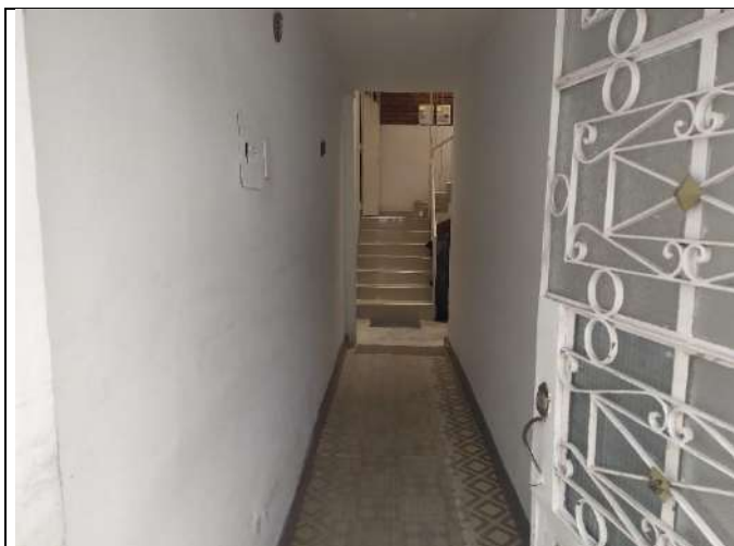
Foto No. 5 Vista general de la construcción
