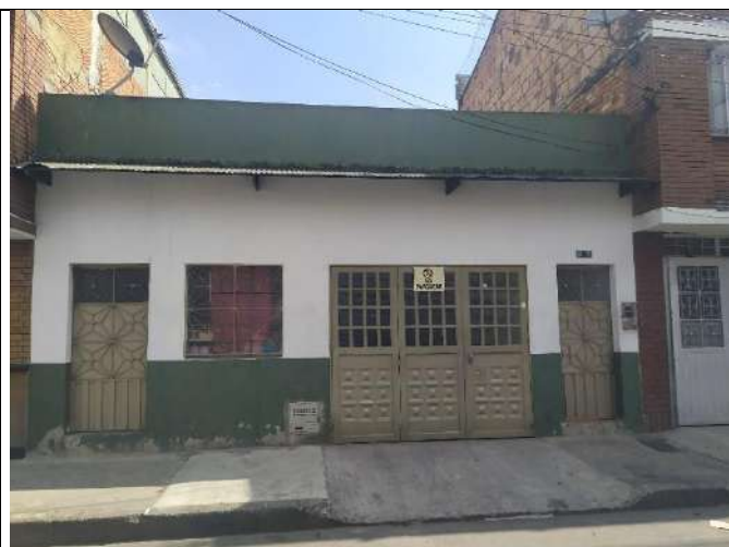
Foto No. 27 Vista general del Lindero Este
