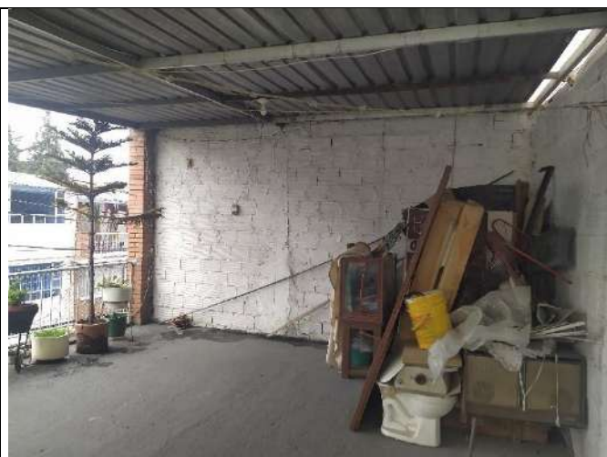
Foto No. 23 Vista general de la construcción
