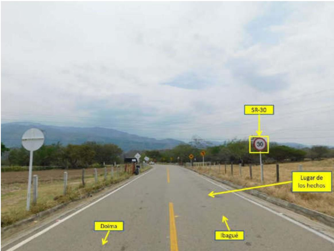
**FOTOGRAFÍA No. 6 PANORÁMICA:** En esta fotografía tomada por el equipo de IRS Vial en sentido Doima – Ibagué a la altura del km 0 + 070 m, se aprecian las características generales de la vía, en la cual se encuentra demarcación horizontal de línea amarilla segmentada y líneas de borde, con señalización vertical SR-30 “Velocidad máxima 30 km/h”; en este sentido se desplazaba el vehículo No. 1 (Motocicleta).
