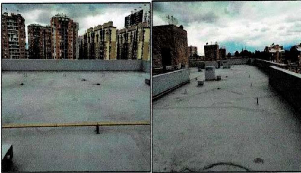
Ha habido rotura del material impermeabilizante en más del 60% del área total de la cubierta y el contratista ejecutor ha realizado recubrimientos a medida que surgen los requerimientos de los residentes por filtraciones de agua desde la cubierta hacia los apartamentos.
