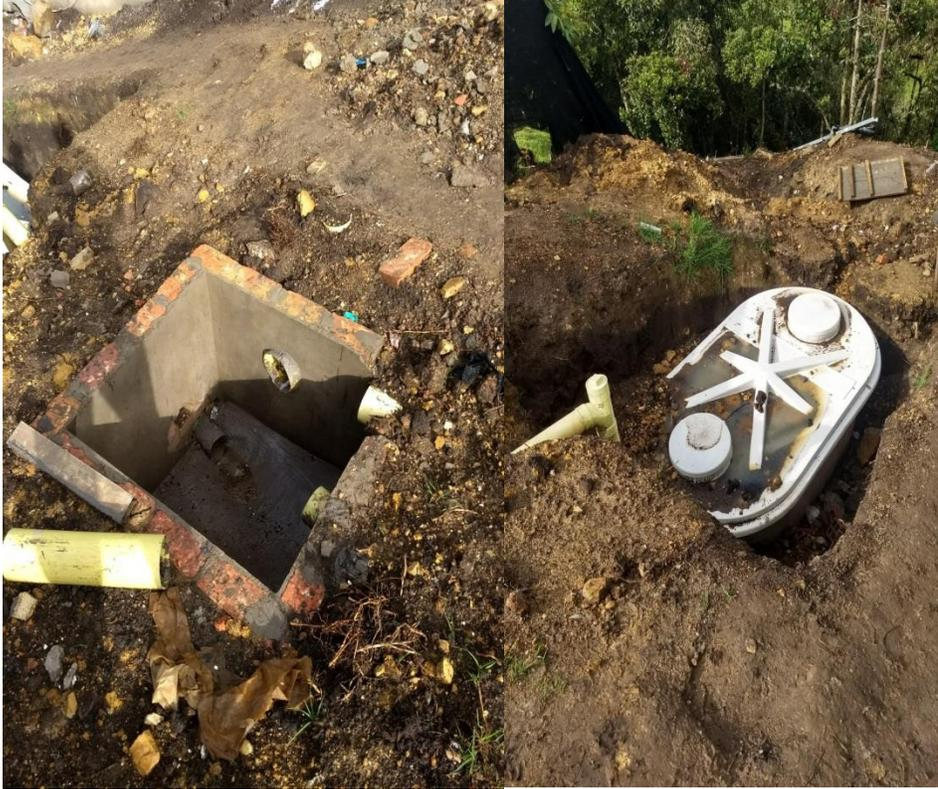
CAJA DE INSPECCION Y POZO SEPTICO
