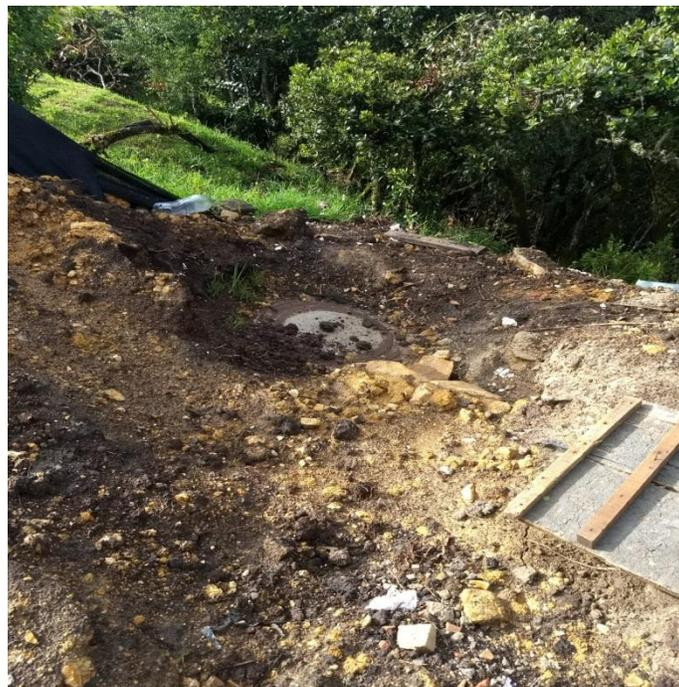
CONEXIÓN A RED DE ALCANTARILLADO
