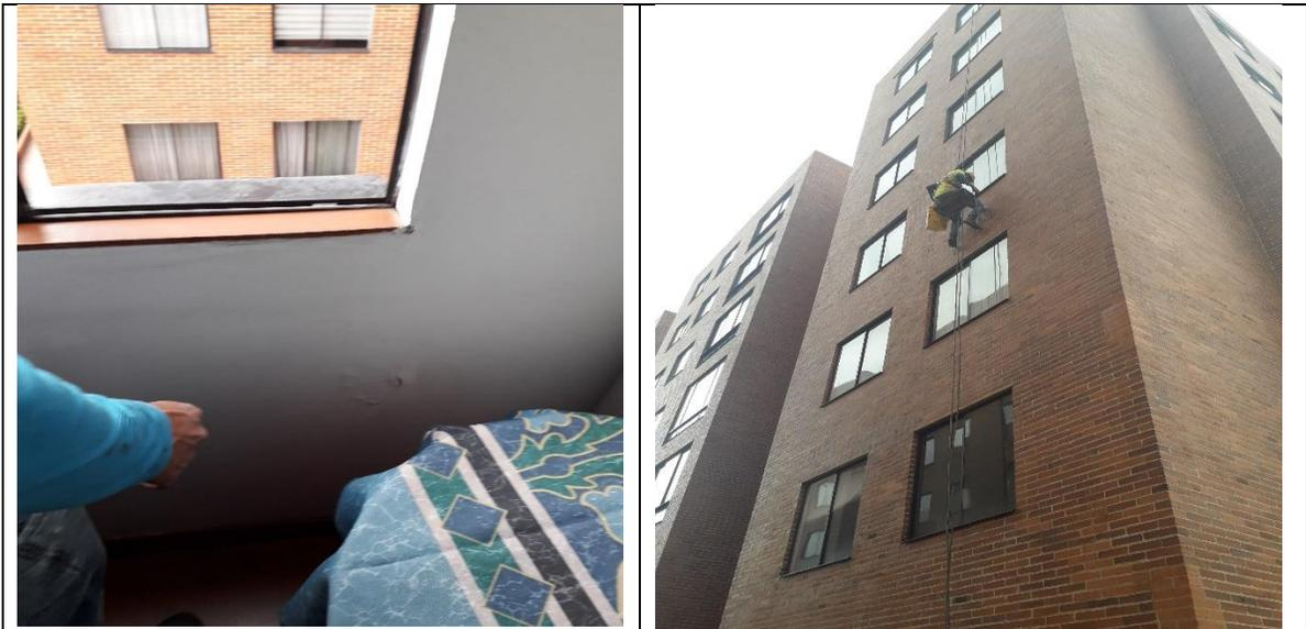
T2-301: Reporto humedad en borde inferior de ventana estudio, Se verifico y se observa que el desnivel de la alfajía esta hacia el interior dl marco de la ventana; Se coloco cordón de silicona en parte inferior de alfajía, para reforzar el área
