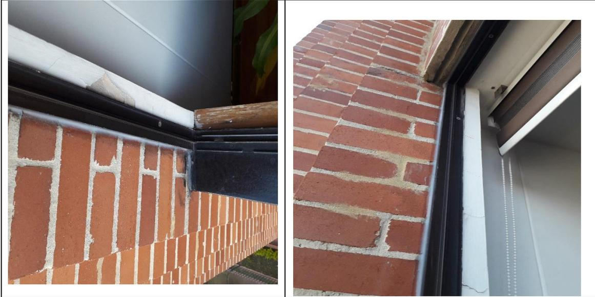
T2-402: Se realizo inspección y se encuentran estucos y pinturas levantados en los muros de las ventanas, y se observa que los empaques de las ventanas están deteriorados se verifica el sello de la silicona exterior sobre ventana y marco encontrándolo en buena condición.
